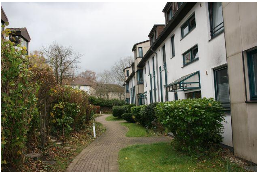
Bild 2 Die Eingangsseite der Gebäudezeile.
