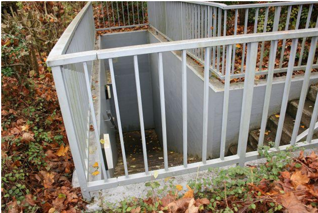
Bild 12 Fluchttreppenhaus aus der Tiefgarage.
