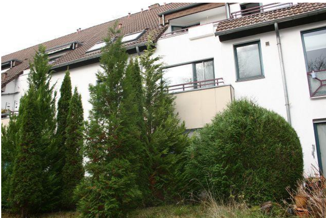
Bild 6 Detailaufnahme mit der zu bewertenden Wohnung im Erdgeschoss.
