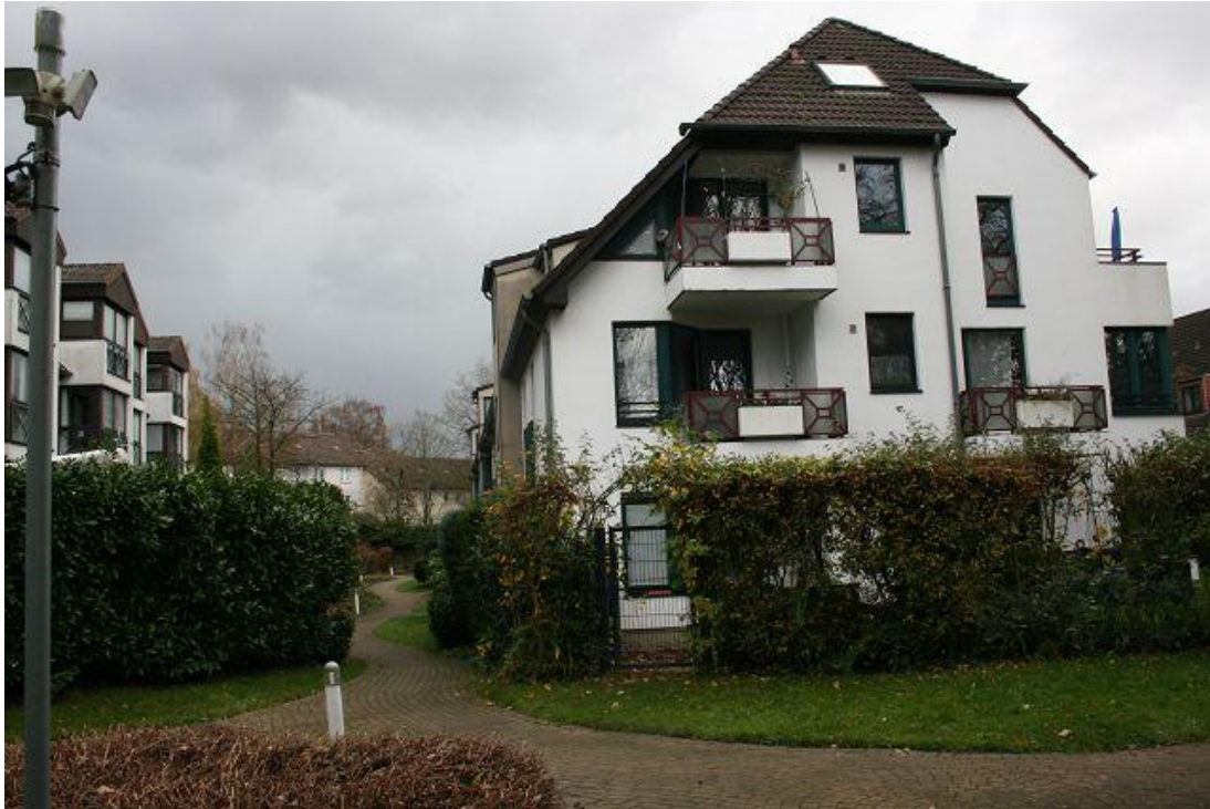
Bild 3 Die westliche Giebelfassade.
