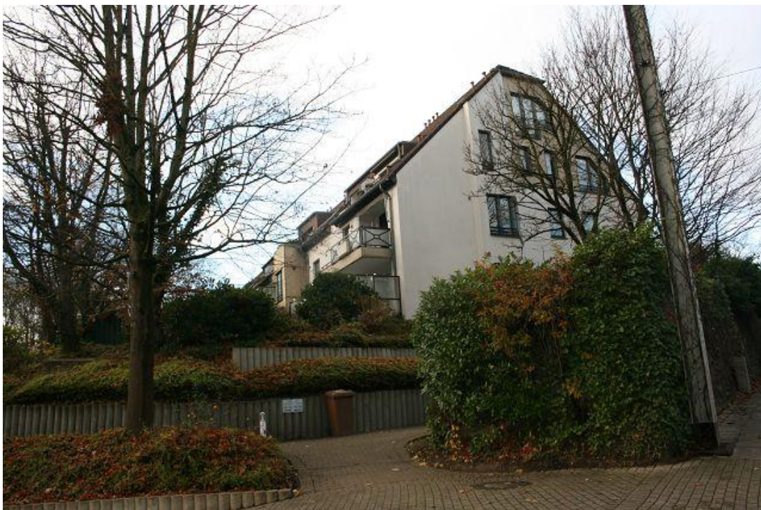
Bild 9 Der Zugang von der Rellinghauser Straße.
