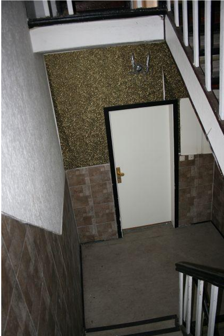
Bild 15 Blick durch das Treppenhaus zum 2. Obergeschoss.
