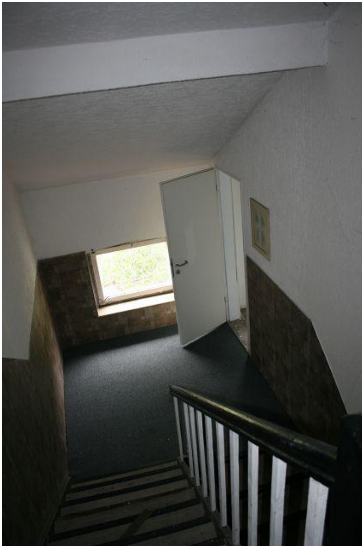
Bild 17 Blick durch das Treppenhaus zum Zwischenpodest.
