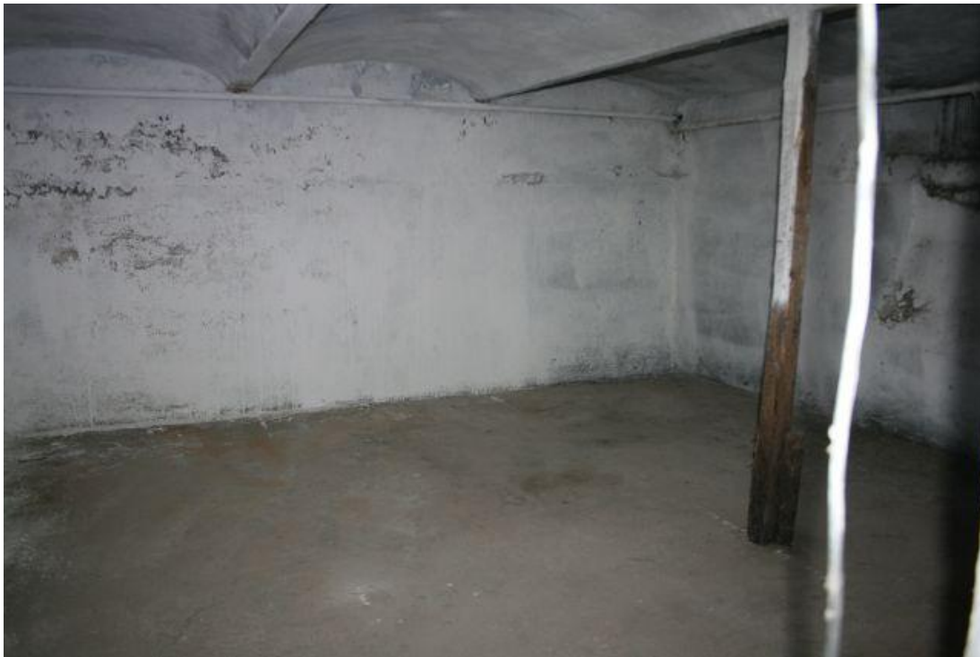
Bild 30 Ein weiterer Kellerraum mit provisorischen Abstützungen.
