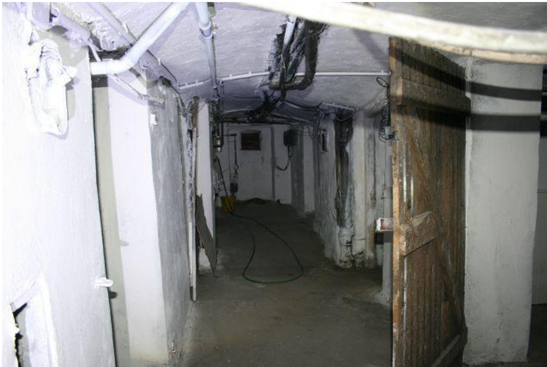
Bild 23 Blick durch den Kellerflur.
