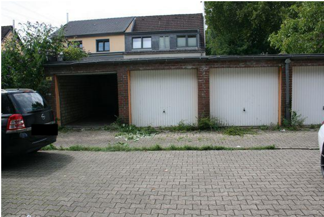
Bild 11 Ergänzende Ansicht der Garagen.
