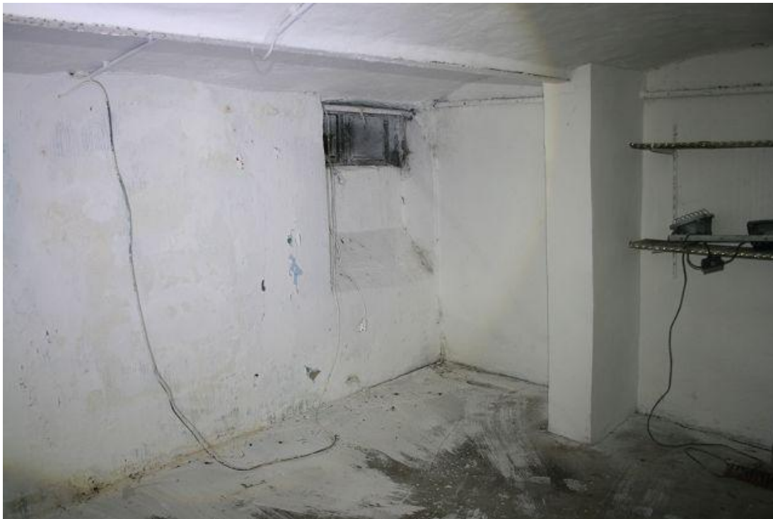
Bild 25 Ein beispielhafter Kellerraum.
