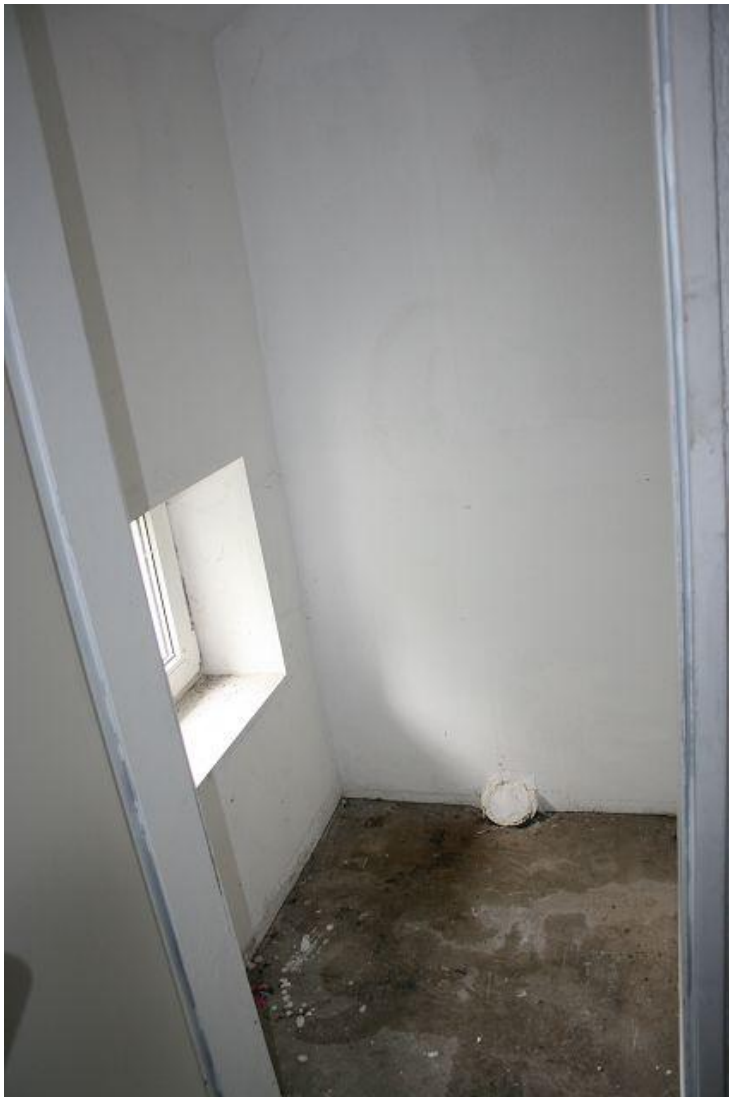
Bild 16 Abstellraum auf dem Zwischenpodest.
