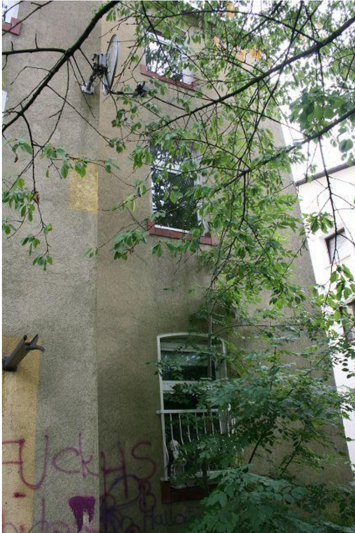
Bild 6 Die Hoffassade rechts.
