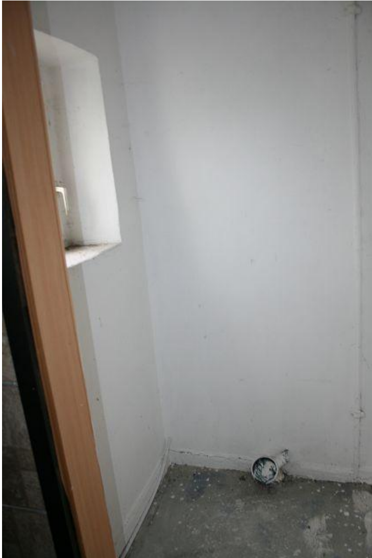
Bild 14 Abstellraum zwischen Erd- und 1. Obergeschoss.
