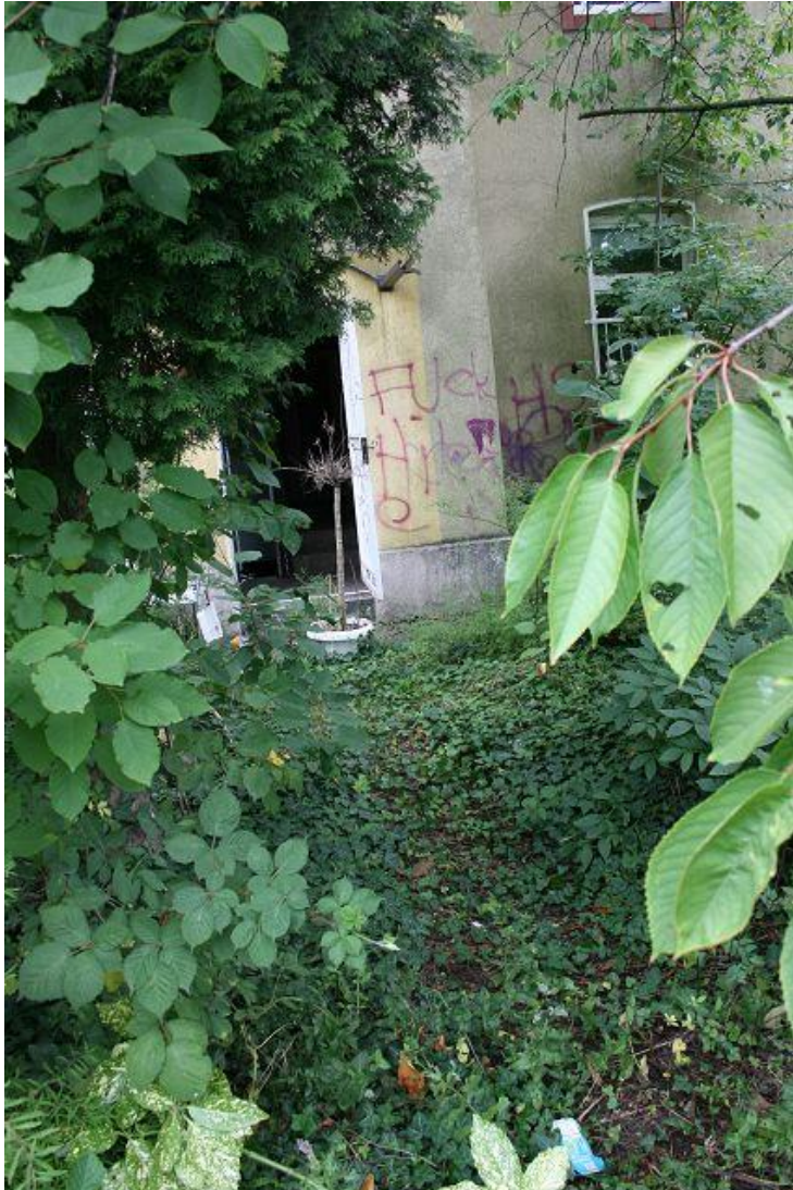
Bild 8 Der verwilderte Gebäudezugang rückseitig.
