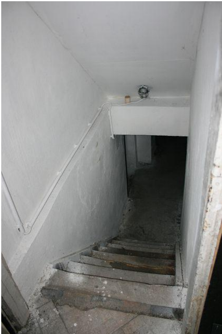
Bild 22 Treppe zum Kellergeschoss.
