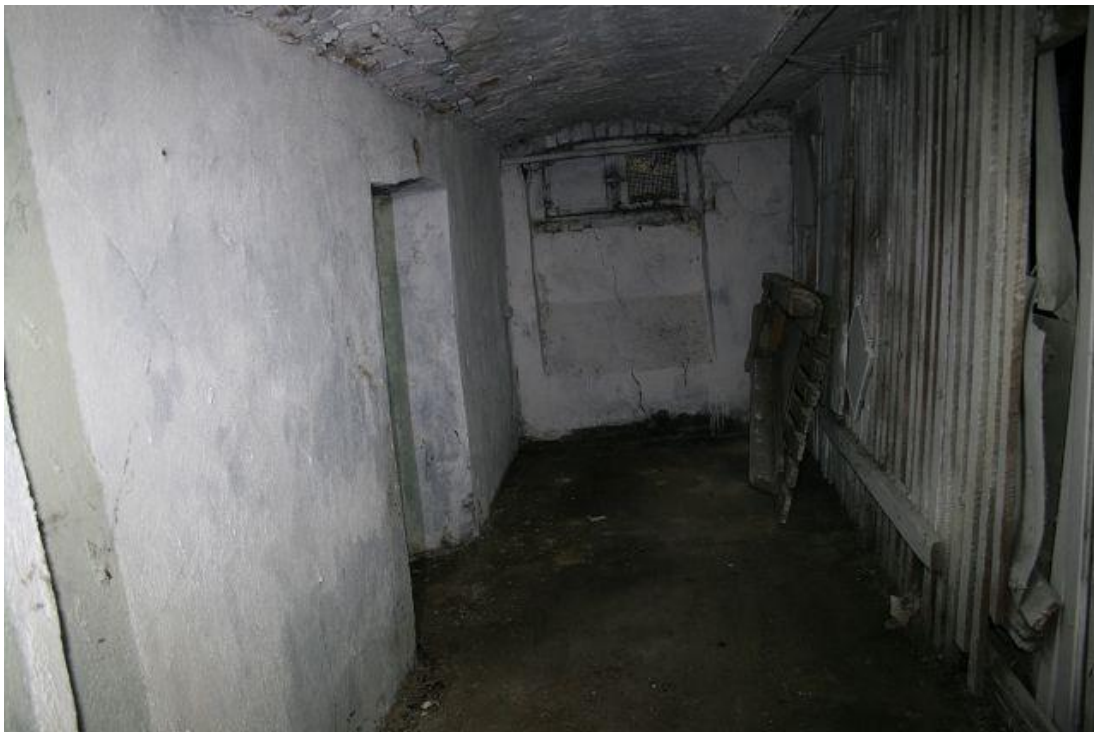
Bild 29 Blick durch einen Kellerflur.
