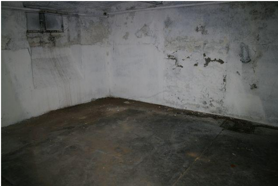
Bild 28 Ein beispielhafter Kellerraum.
