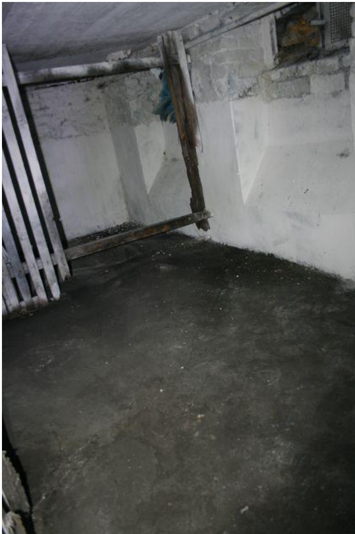
Bild 27 Ein beispielhafter Kellerraum.
