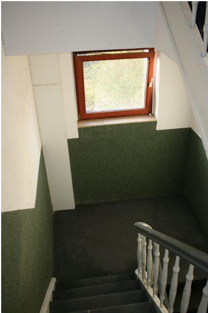
Bild 5 Blick durch das Treppenhaus.
