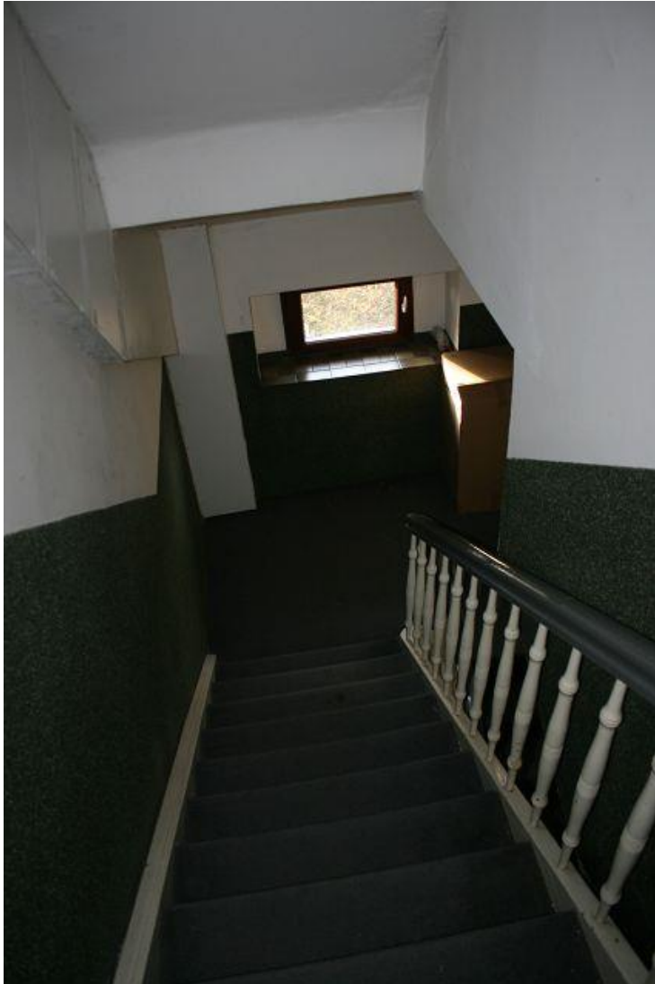
Bild 6 Ergänzender Blick durch das Treppenhaus vom Dachgeschoss.
