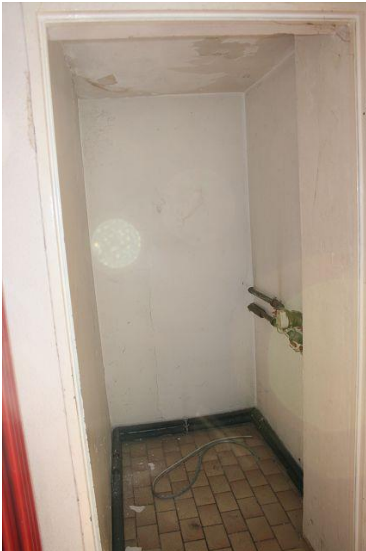
Bild 18 Von der Küche abgehender Abstellraum.
