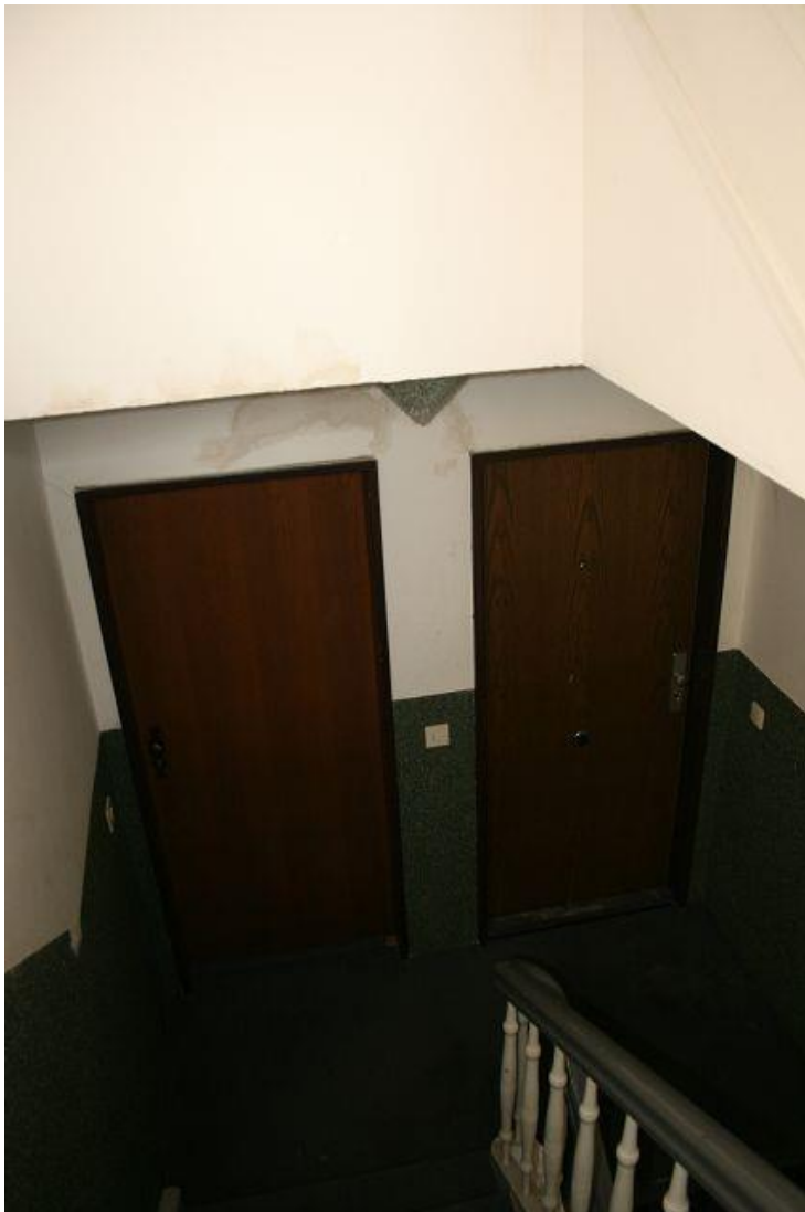
Bild 14 Zugangstüren zur Wohnung Nr. 3 im 1. Obergeschoss.
