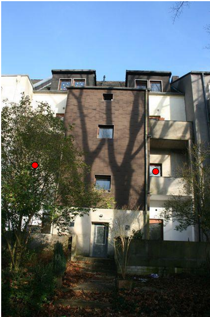
Bild 3 Die Gebäuderückseite mit der zu bewertenden Wohnung im 1. Obergeschoss.
