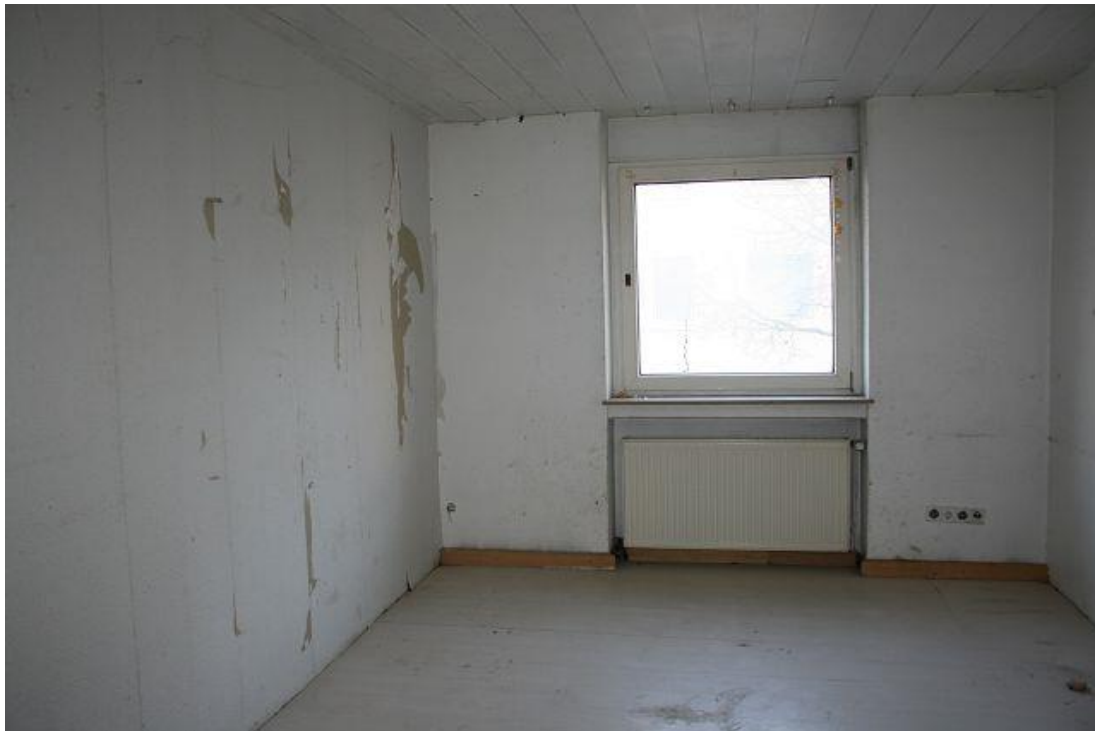
Bild 24 Straßenseitiger Wohnraum in Gebäudemitte.
