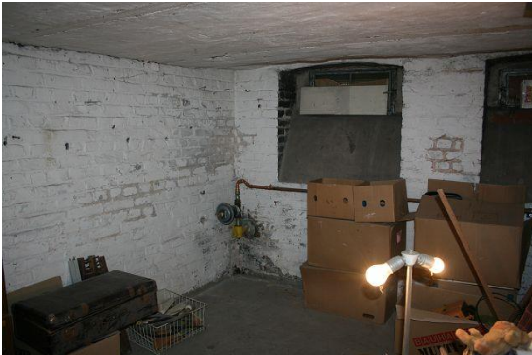
Bild 12 Der Kellerraum Nr. 8.
