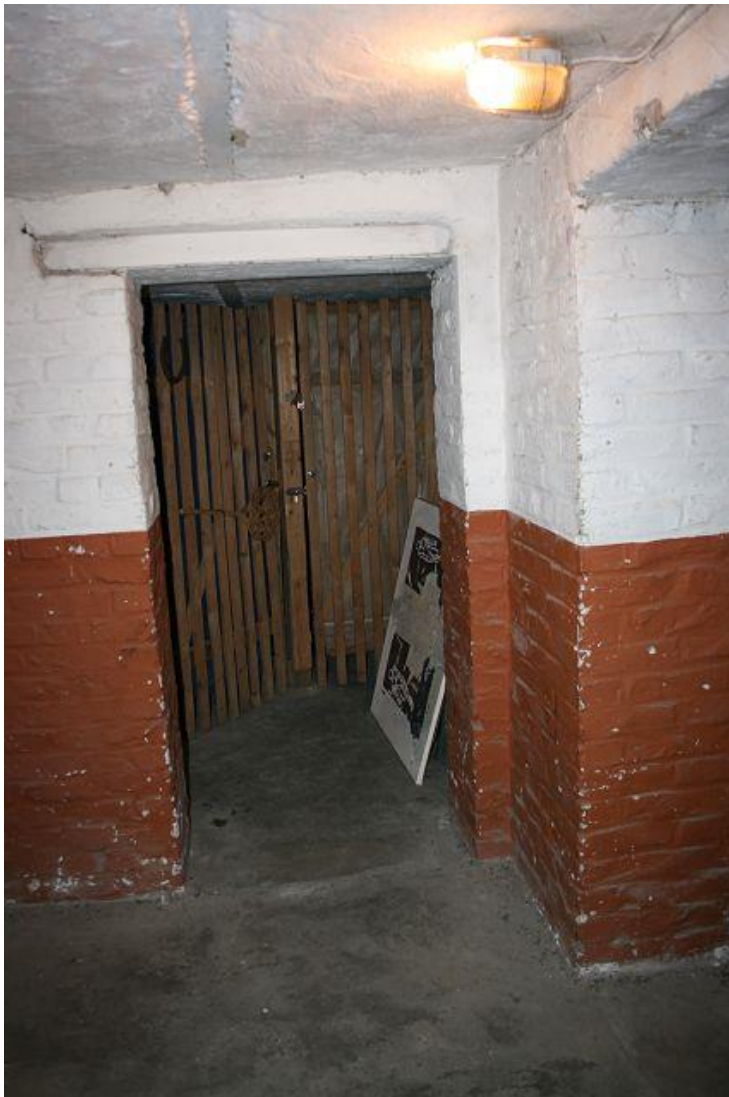
Bild 9 Blick durch den Kellerflur.
