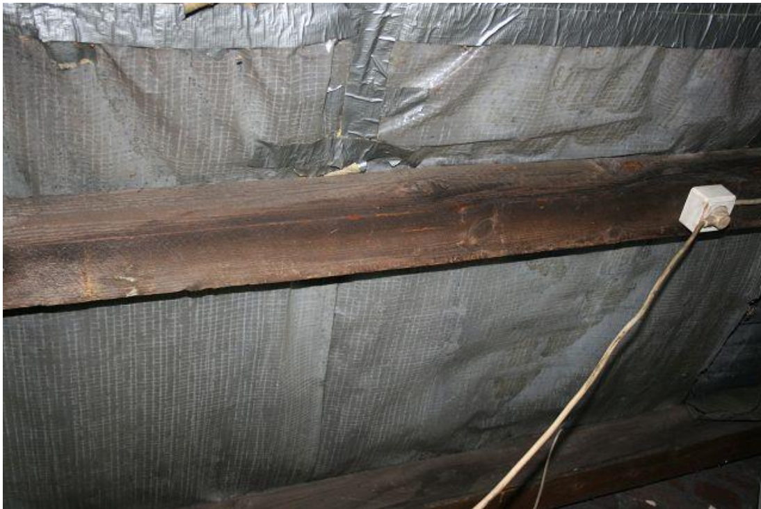
Bild 7 Detailaufnahme der Dachkonstruktion.
