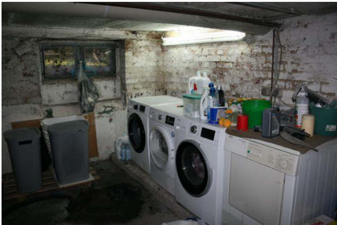
Bild 12 Blick durch die Waschküche.
