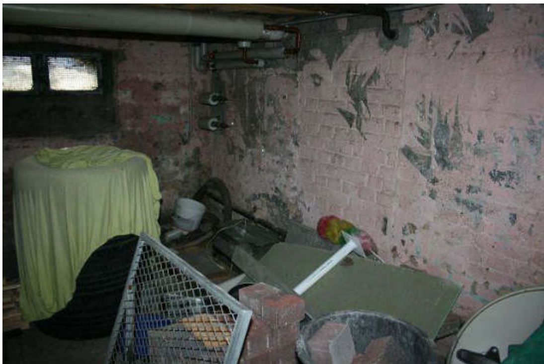
Bild 15 Gemeinschaftskeller mit diversem Sperrmüll.
