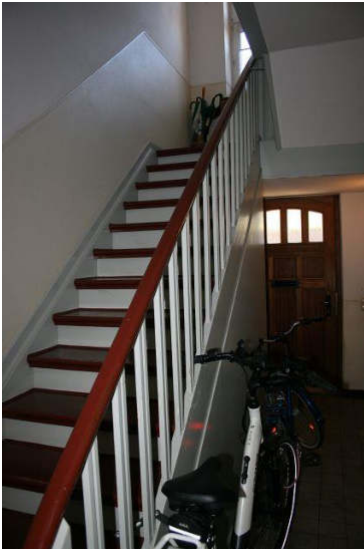
Bild 8 Blick in Gegenrichtung mit der Treppenanlage.
