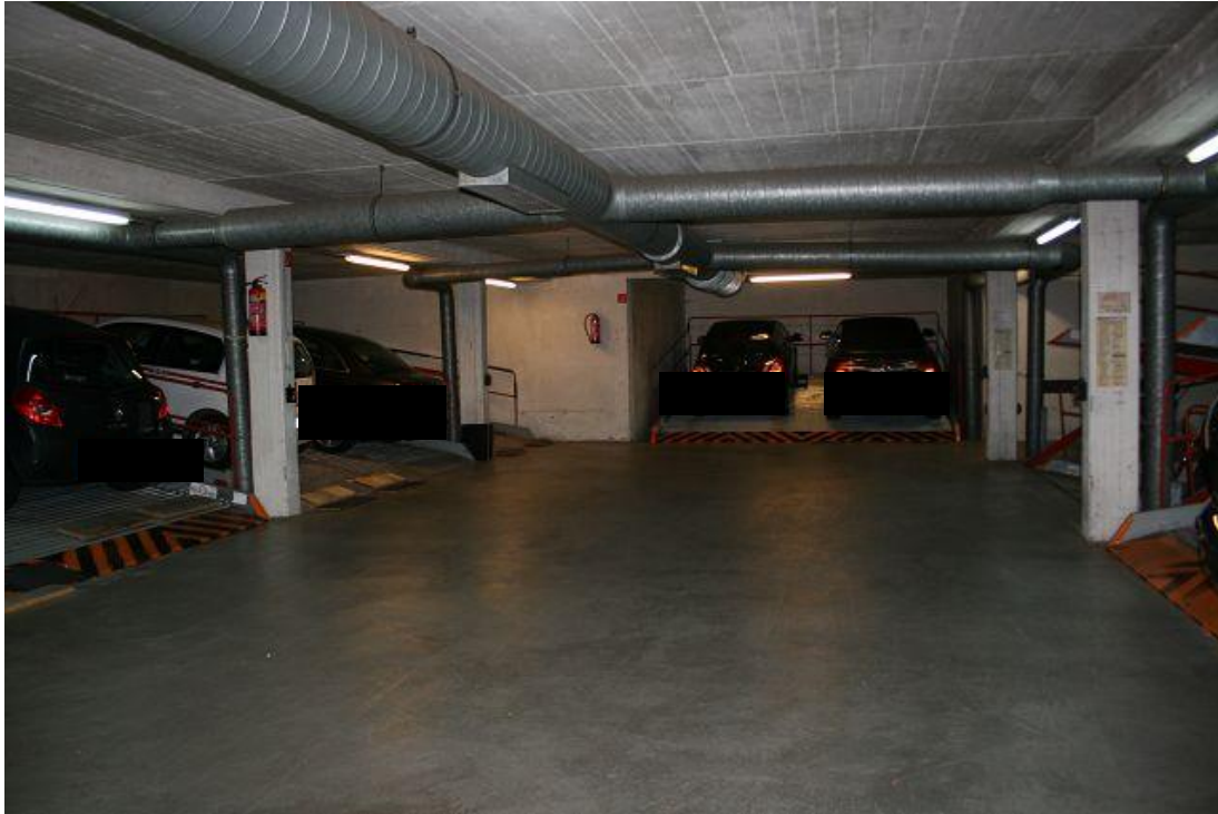
Bild 15 Blick durch die Tiefgarage mit Doppelparkern.
