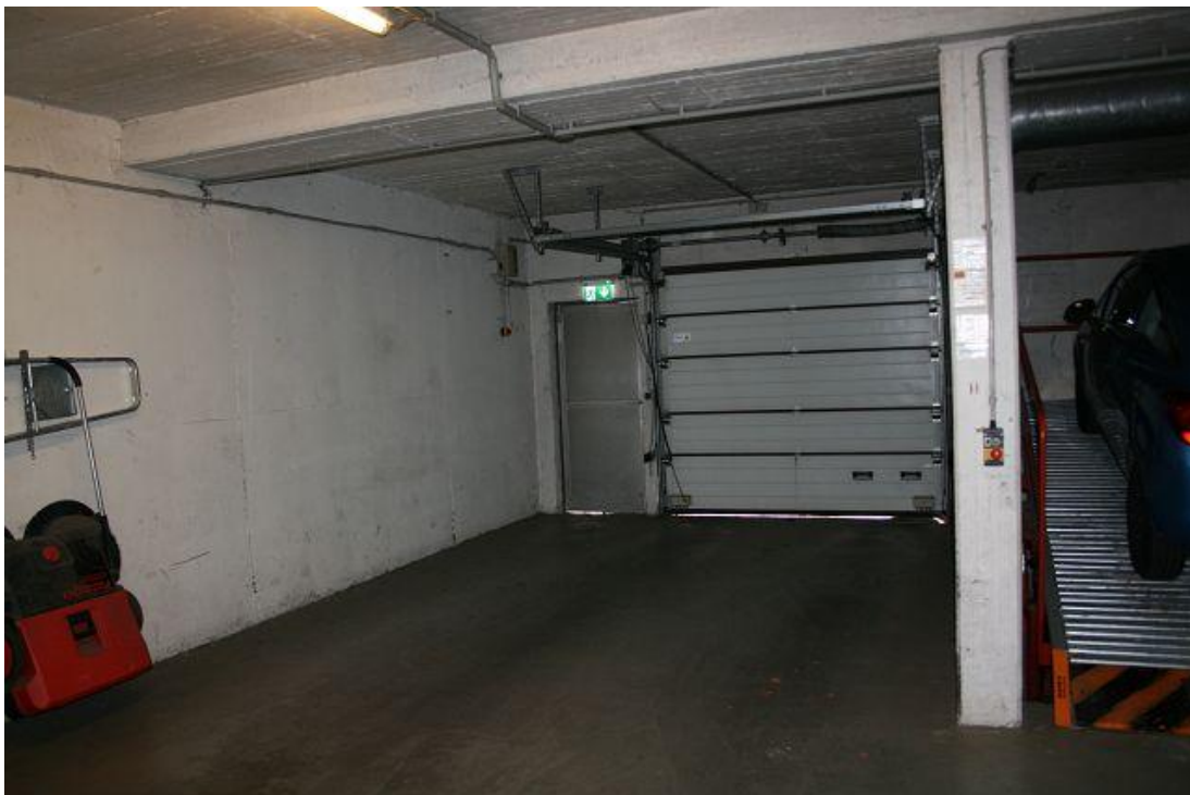
Bild 16 Detailaufnahme des Zufahrtstores.
