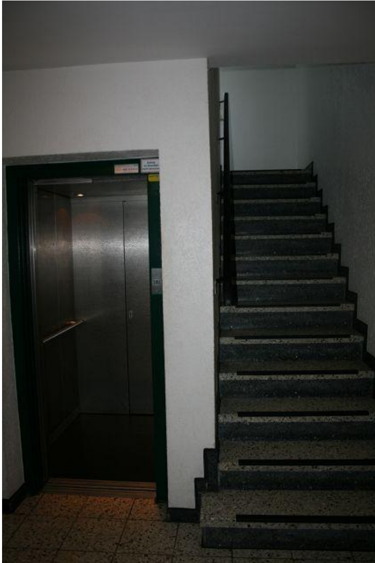
Bild 10 Das Treppenhaus mit Aufzug.
