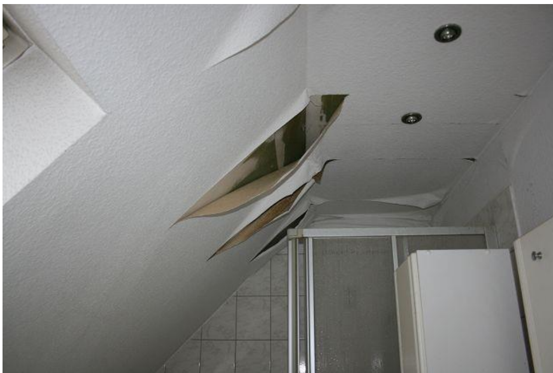
Bild 17 Abgelöste Tapeten im Sanitärraum.
