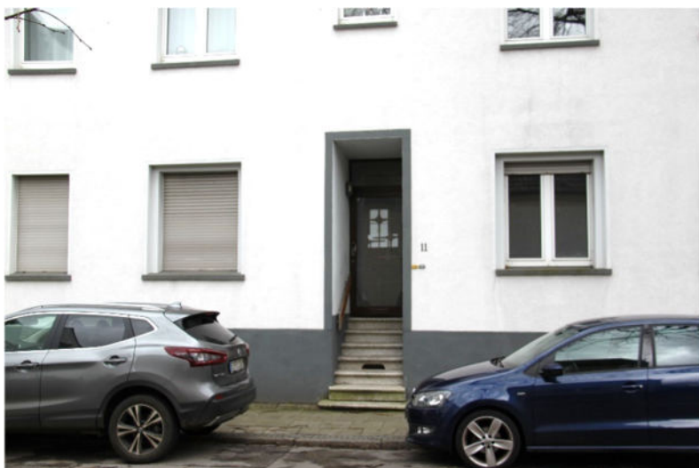
Bild 3 wie vor, Hauseingang
