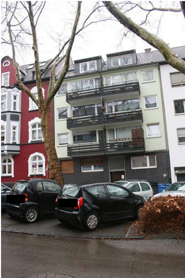
Bild 1 Straßenansicht der WEG-Anlage.
