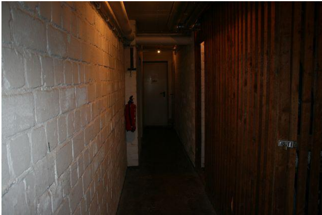
Bild 10 Blick durch den Kellerbereich mit Mieterkellern.
