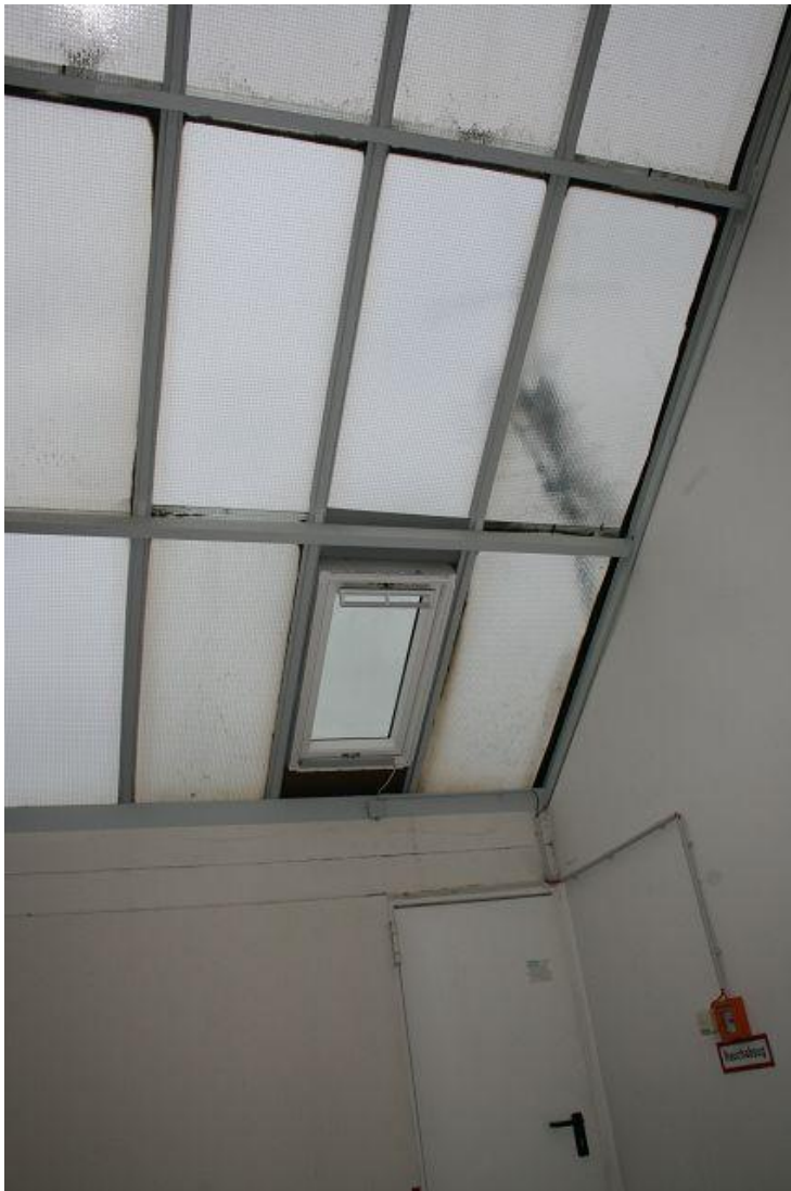
Bild 9 Verglaste Fläche oberhalb des Treppenhauses.
