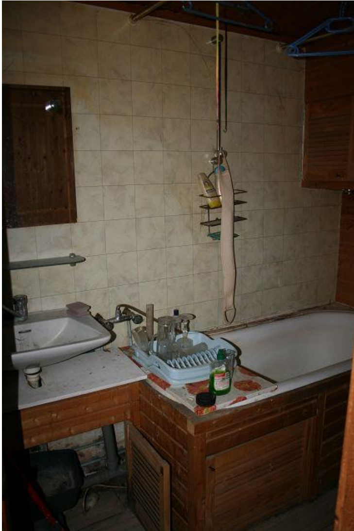
Bild 15 Der weitere Sanitärraum.
