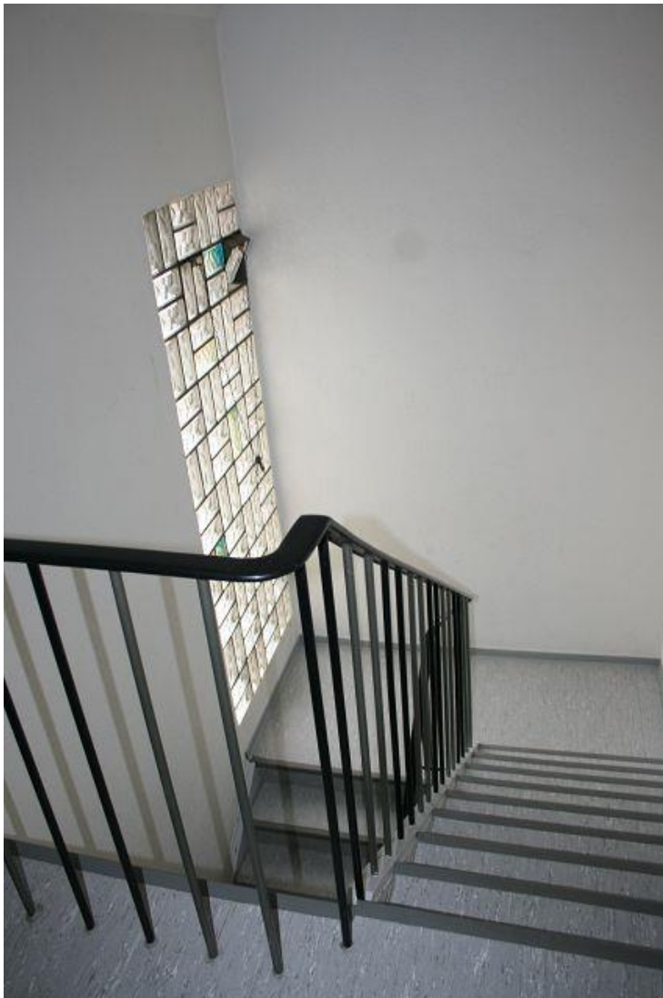
Bild 8 Das Treppenhaus nach unten.
