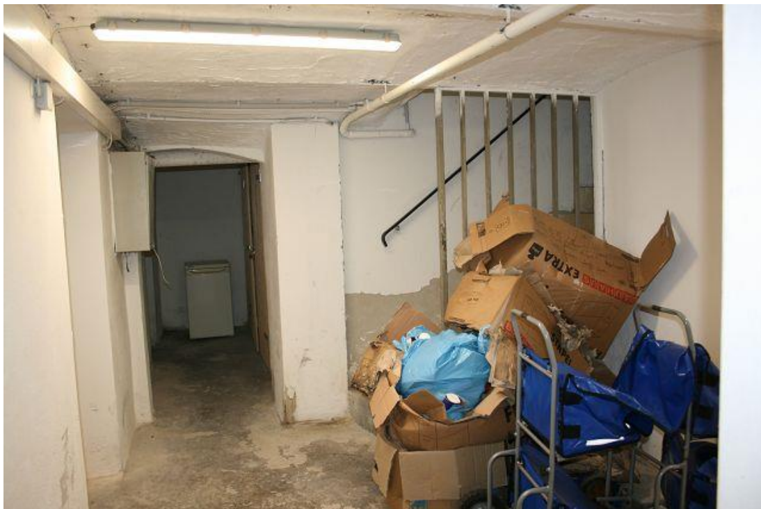
Bild 10 Flur im Kellergeschoss.
