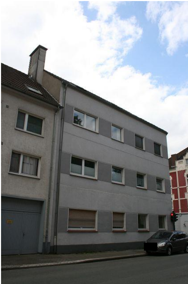
Bild 2 Das Gebäude zur Kupferdreher Straße.
