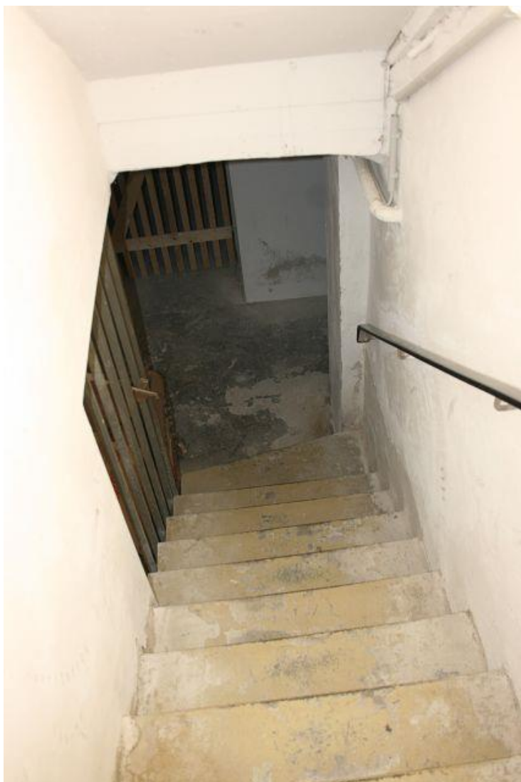
Bild 9 Treppe zum Kellergeschoss.
