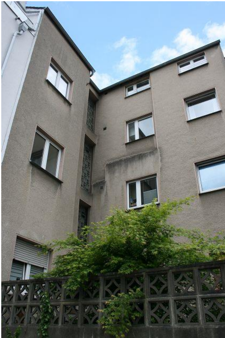
Bild 5 Detailaufnahme der Hoffassade.
