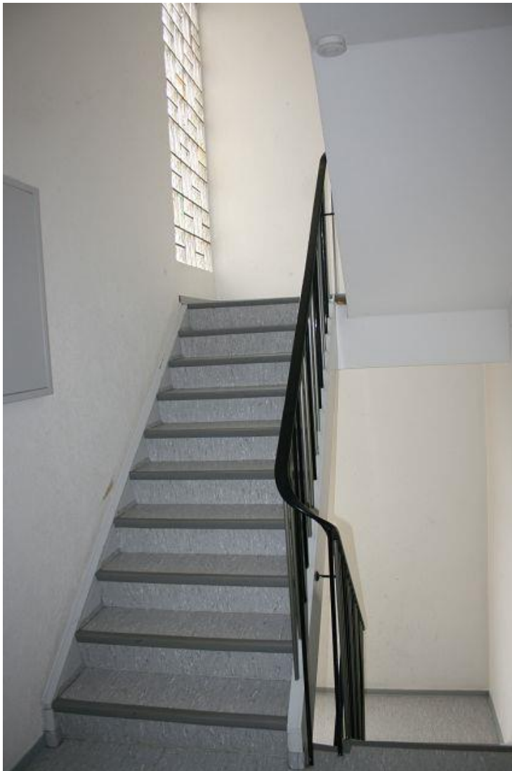
Bild 7 Das Treppenhaus nach oben.
