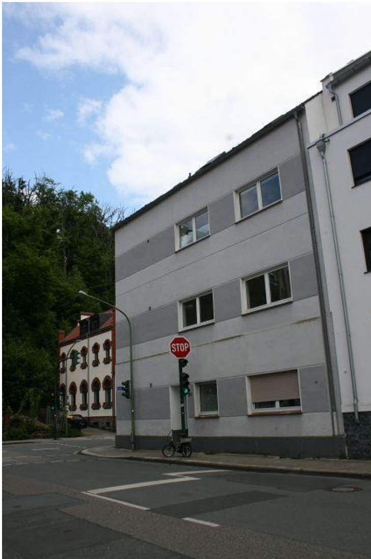
Bild 3 Das Gebäude zur „Deilbachbrücke“.
