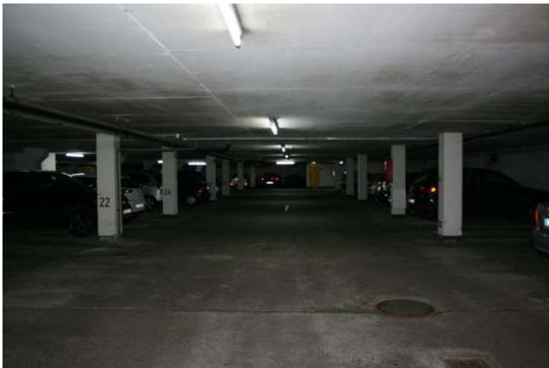
Bild 20 Blick durch die Tiefgarage (2021).
