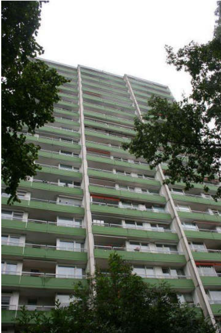
Bild 3 Die Südseite des Hochhauses.
