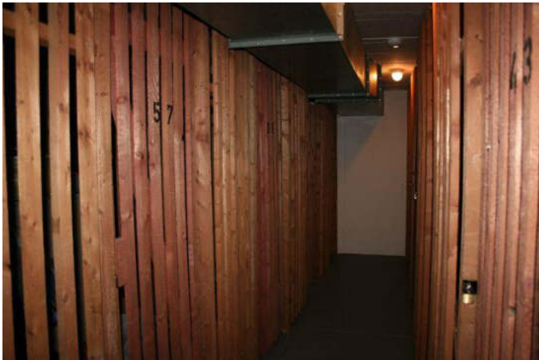
Bild 17 Abstellbereich mit dem der Wohnung zugeordneten Abstellraum links (2021).
