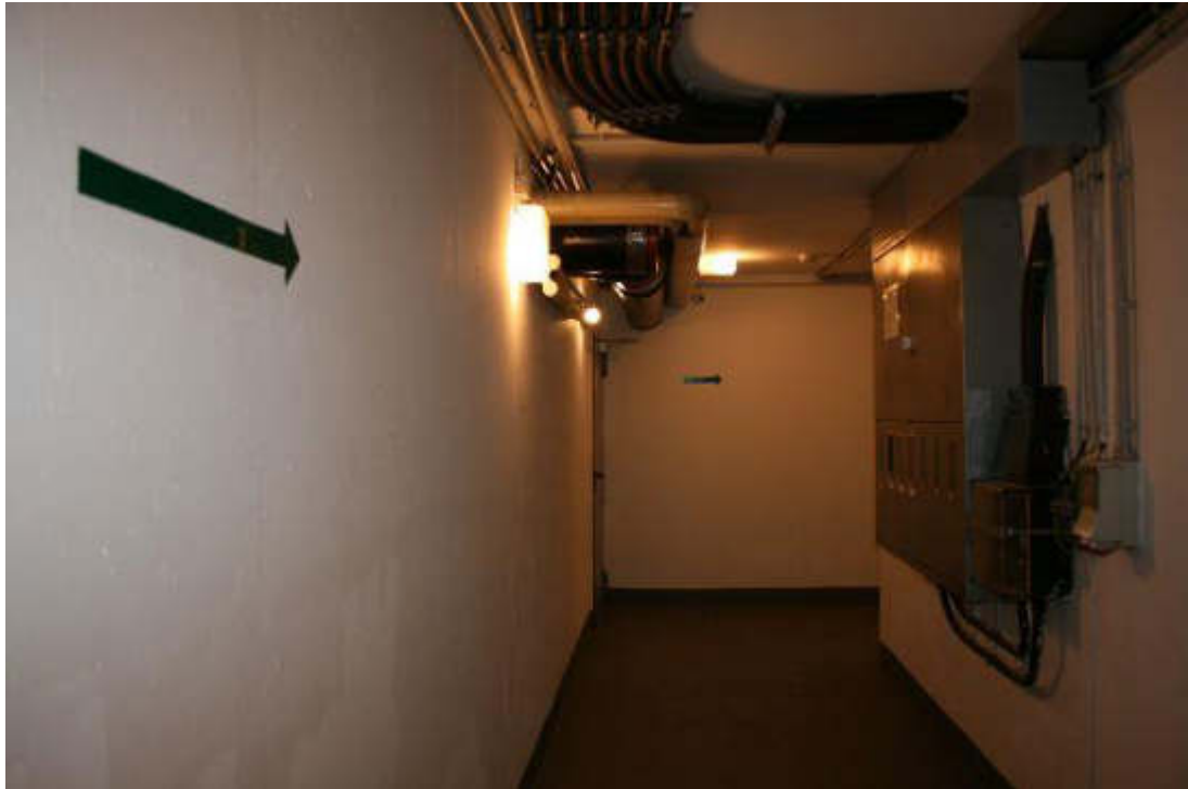
Bild 16 Beispielhafter Flur zu den Abstellräumen im Erdgeschoss (2021).
