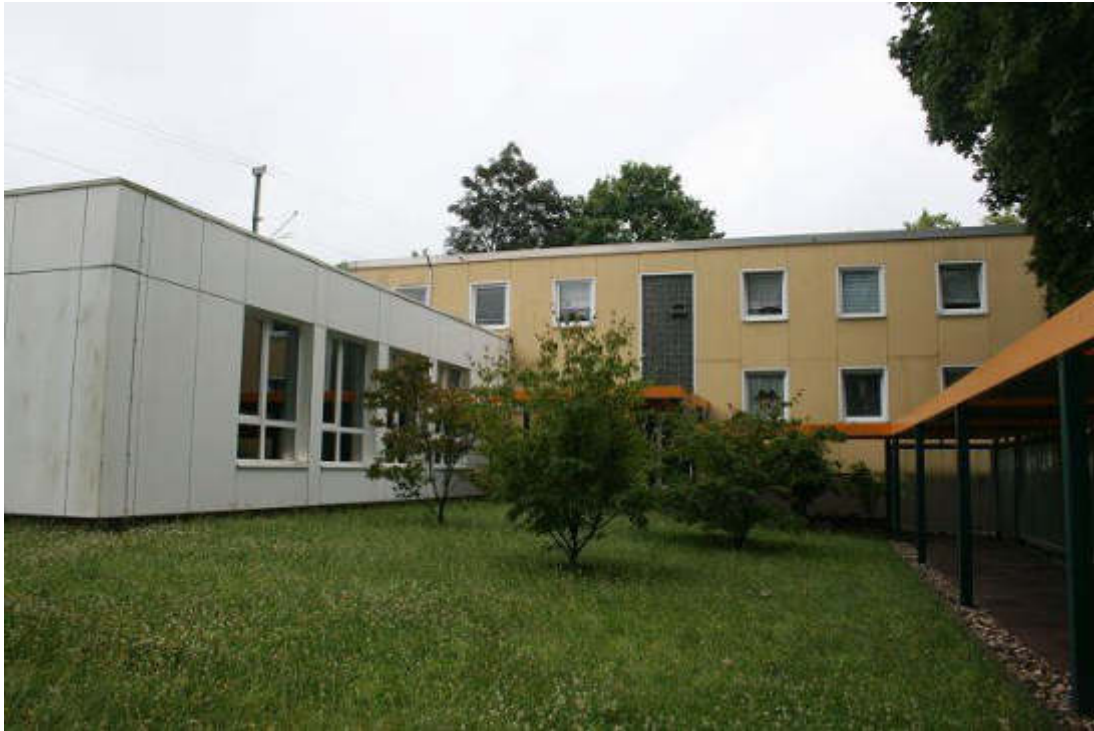
Bild 5 Der Zugangsbereich zum Gebäude Bochumer Straße 66.
