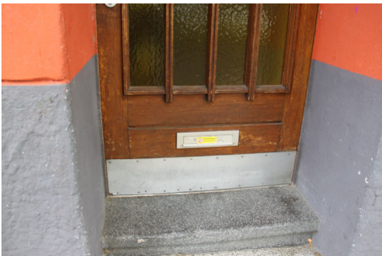
Bild 2 wie vor, Hauseingang Holztür mit Verglasung (einfachverglast)
