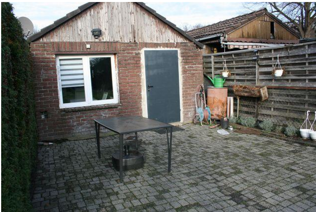
Bild 12 Das Nebengebäude am hinteren Grundstücksende.
