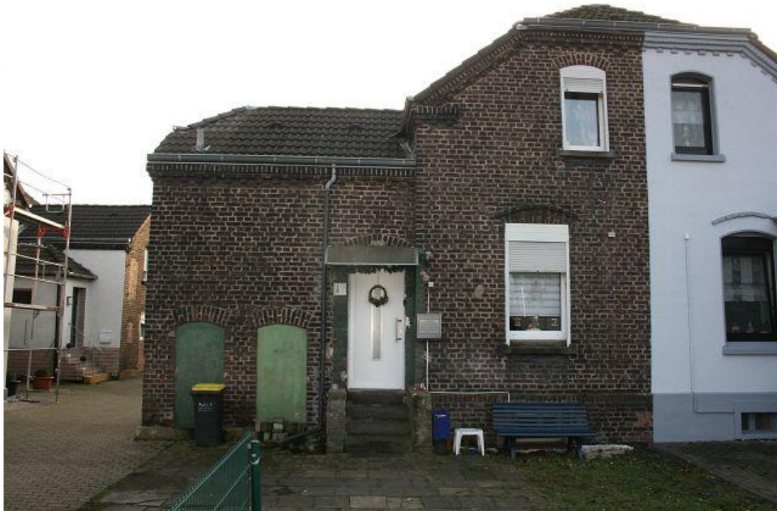
Bild 5 Nordansicht des Wohnhauses mit Gebäudeeingang.
