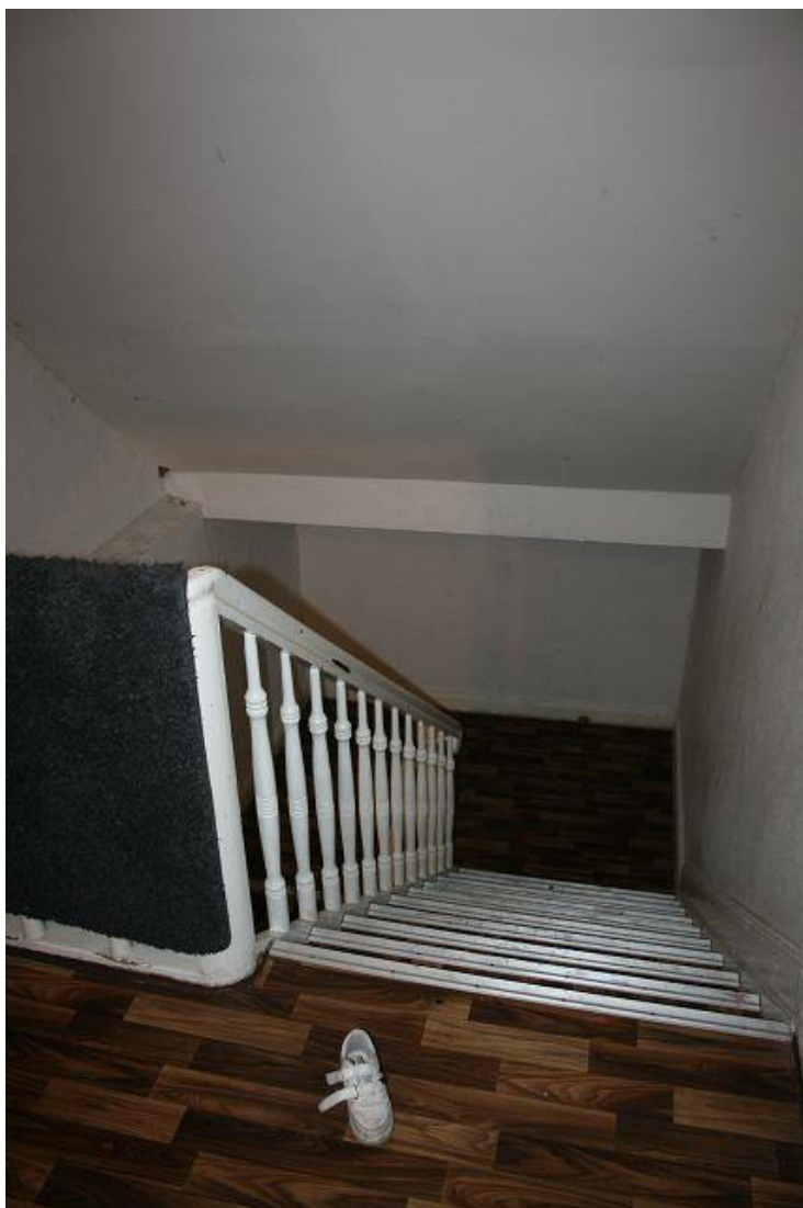
Bild 19 Treppe zum Dachgeschoss mit erheblich eingeschränkter Durchgangshöhe.
