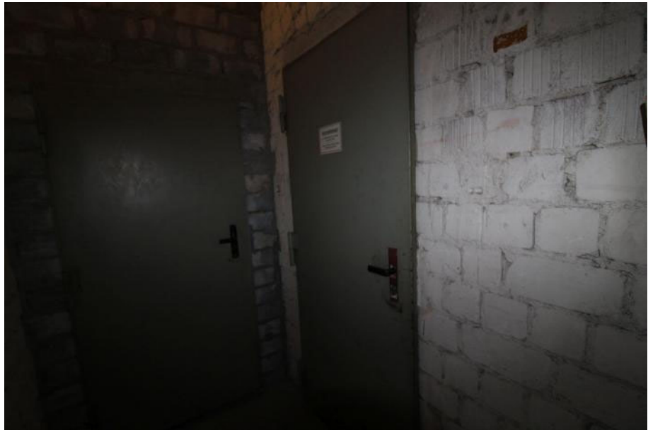
Sicht auf die verschlossene Tür zum Heizungsraum / UG
