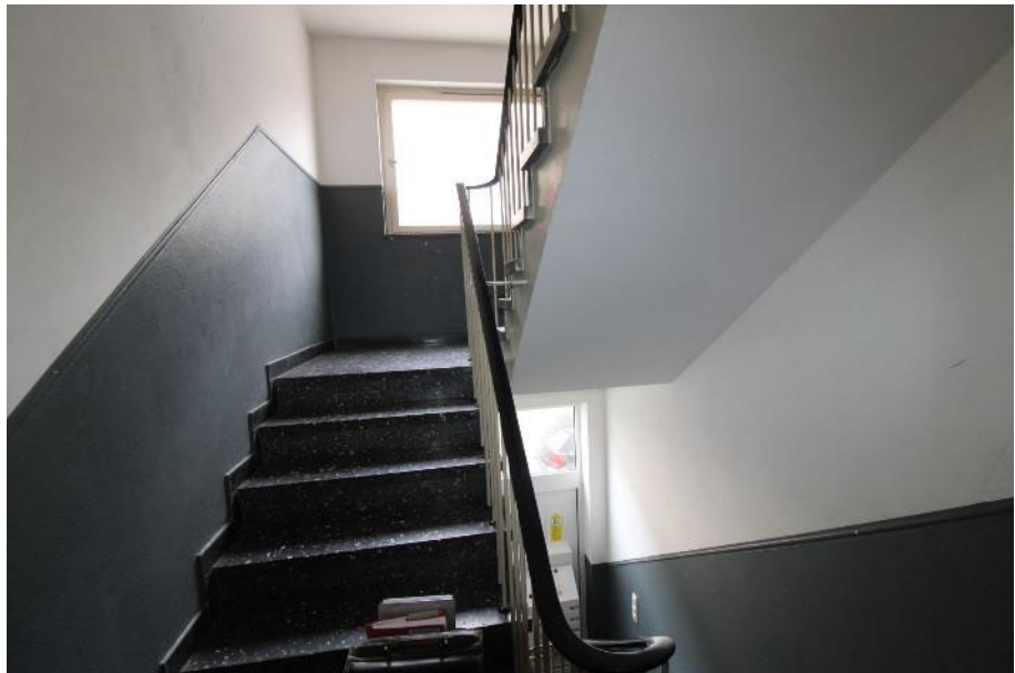
Sicht in das Treppenhaus / EG
