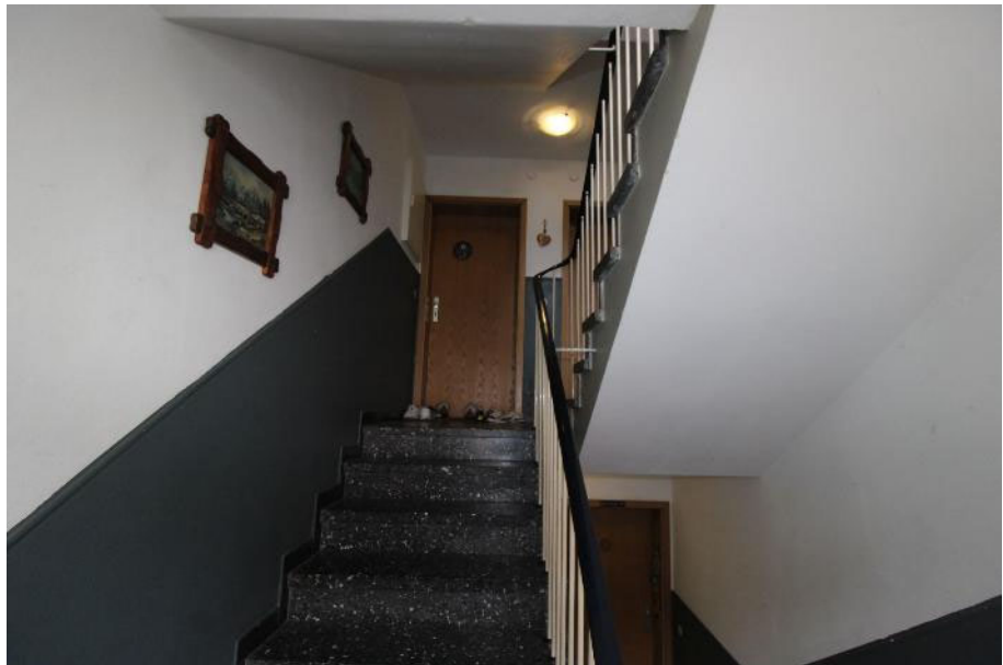
Sicht in das Treppenhaus / 1.OG
