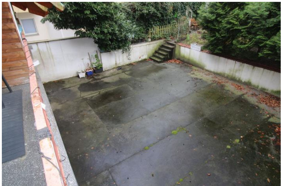
Sicht vom Balkon im EG aus auf den Hof
