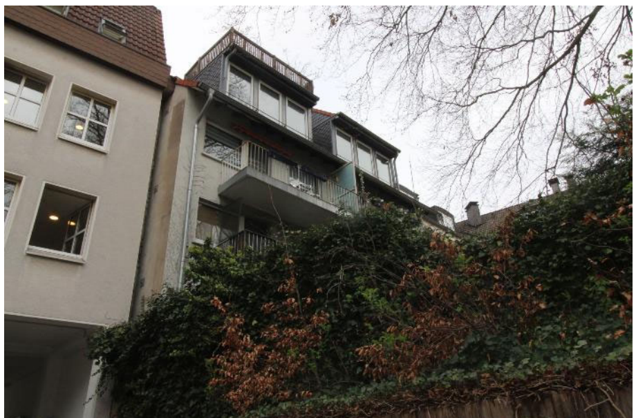
Sicht vom Nachbarflur- stück 287 aus auf die Rückfassade des Wohnhauses
