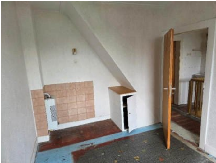
Bild 14 Wohnung rechts, Obergeschoss Blick in das Kinderzimmer. Hinten links sieht man einen kleinen Gasofen. Hinter der Schräge befindet sich die Treppe zum Dachgeschoss.
