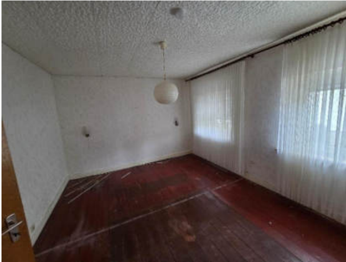
Bild 13 Wohnung rechts, Obergeschoss Blick in das Schlafzimmer. Gleiche Ausstattung wie in den anderen Räumen.
