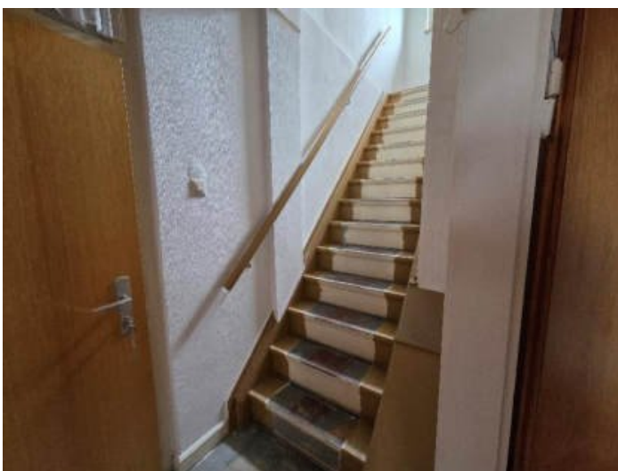
Bild 06 Wohnung rechts, Erdgeschoss Blick in den Flur mit dem Treppenaufgang in das Obergeschoss. Links sieht man die Wohnungseingangstür. Die einläufige Treppe ist aus Holz mit einem Holzhandlauf an der Wand. Die Treppe ist vom Steigungsverhältnis her zu steil, müsste jedoch aufgrund des Bestandsschutzes nicht zwingend erneuert werden (ist jedoch anzuraten).
