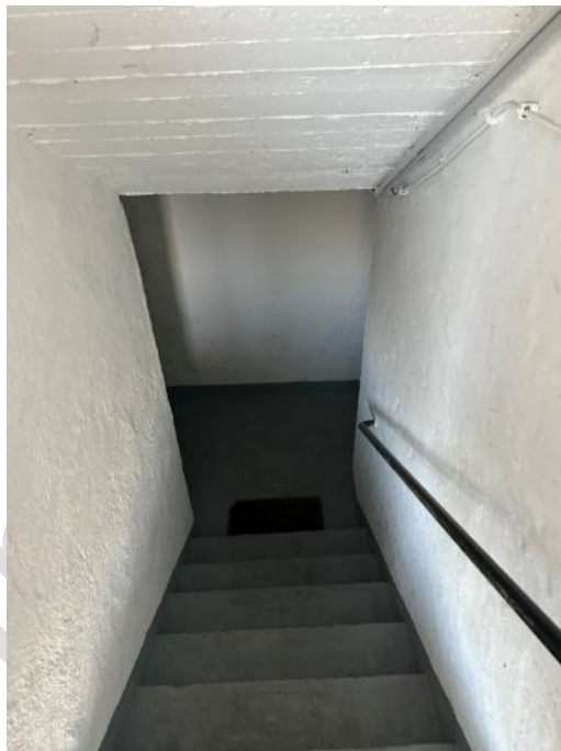
Kellerabgang vom Treppenhaus
