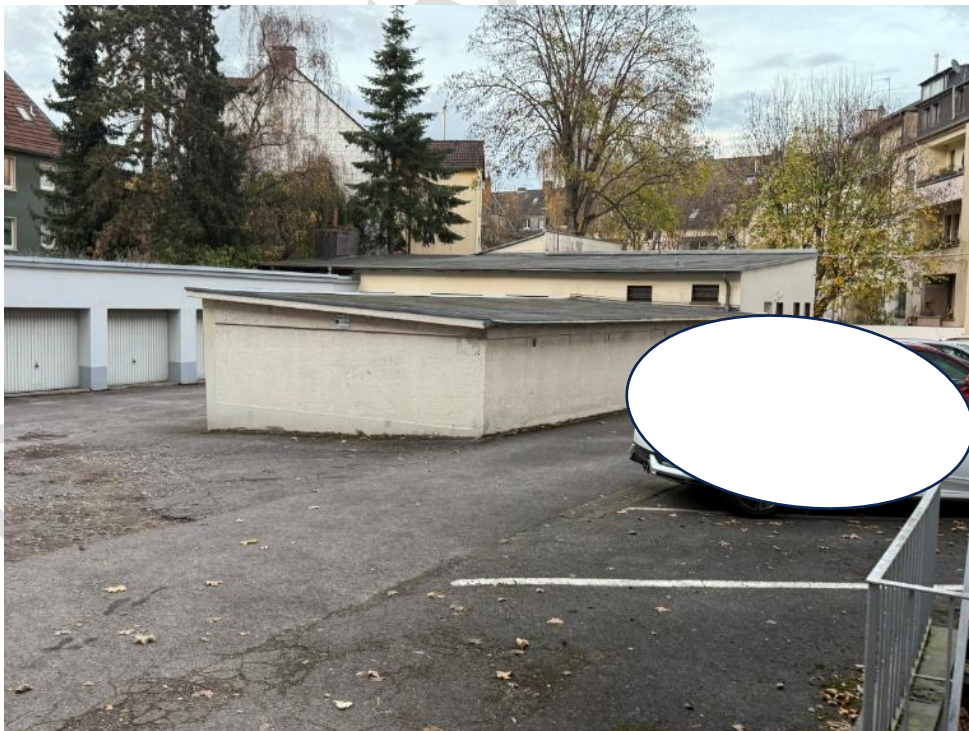
Garagen im rückwärtigen Grundstücksteil
