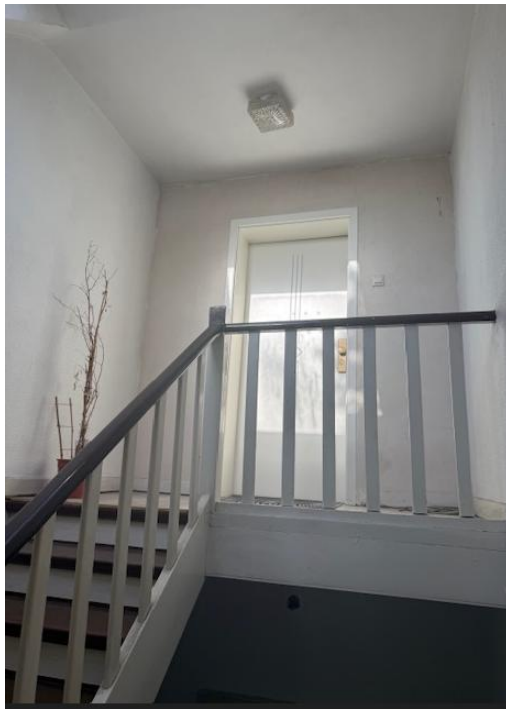
Treppenhaus Eingang Wohnung Spitzboden
