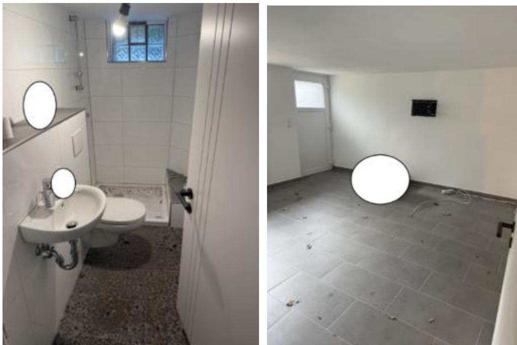
Kellergeschoss: Badezimmer und Raum zur Gartenseite
