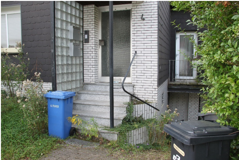
Bild 2 wie vor, Hauseingangstreppe mit Vordach
