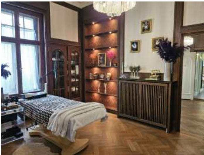
Bild 20 SE-Nr. 2, Beautysalon. Blick in den Behandlungsraum. Vor den einfachverglasten Fenstern wurden Holzfenster mit Isolierverglasung vorgesetzt. Auf dem Boden befindet sich ein Holzbelag. In den Wandaussparungen wurden Holzregale und Einbauschränke integriert.
