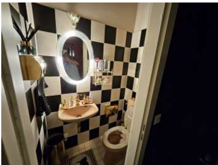
Bild 21 SE-Nr. 2, Beautysalon. Blick in das WC. Die Wände sind raumhochgefliest, darüber Putz und Anstrich. Ausstattung mit Handwaschbecken und WC. Der Boden hat ebenfalls einen Keramikplattenbelag.
