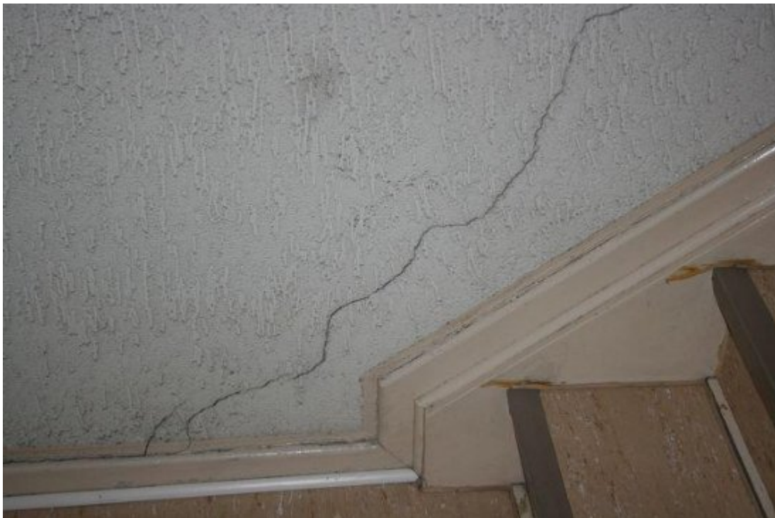
Bild 7 Detailaufnahme von Rissbildungen im Treppenhaus.
