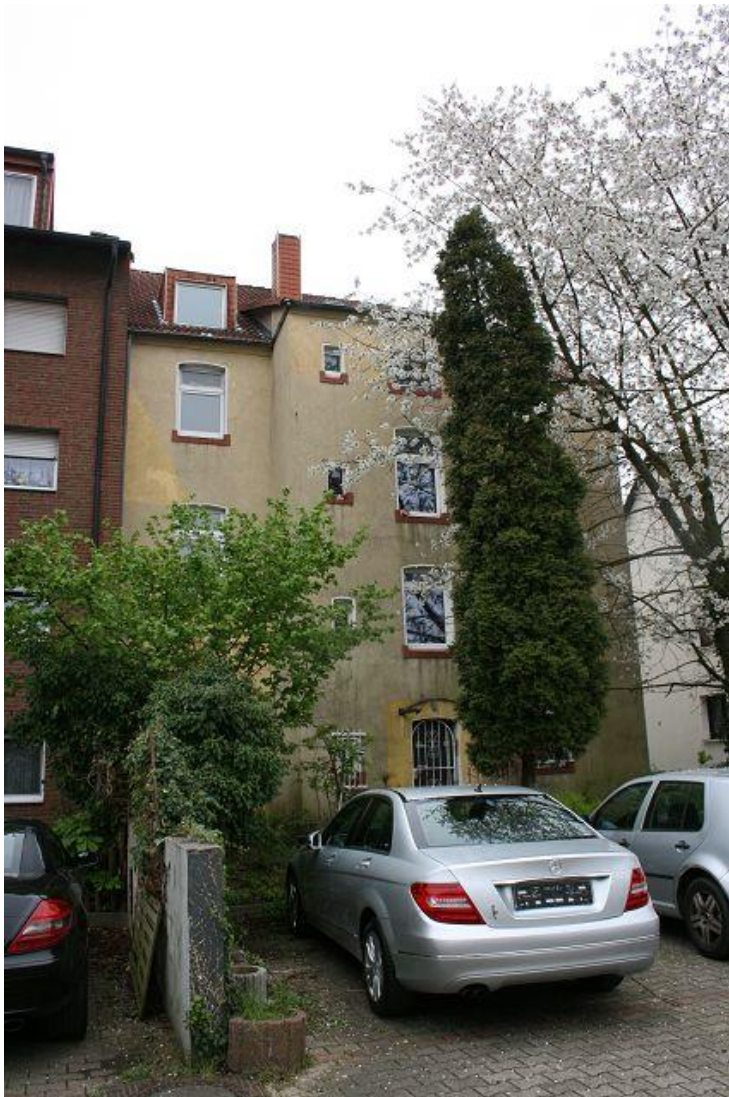
Bild 6 Ergänzende Rückansicht des Gesamtgebäudes.
