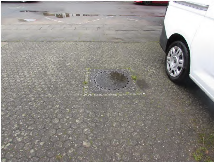
Foto 9: Zufahrt (mit Kanaldeckel zum Einstiegsschacht (Abt. II, lfd. Nr. 1))
