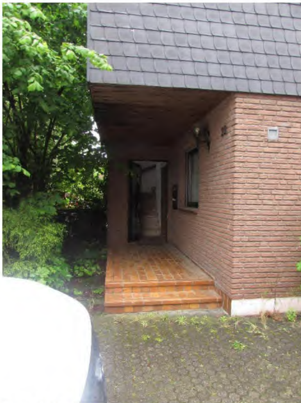
Foto 2: Hauseingang mit Überdachung durch die Loggia
