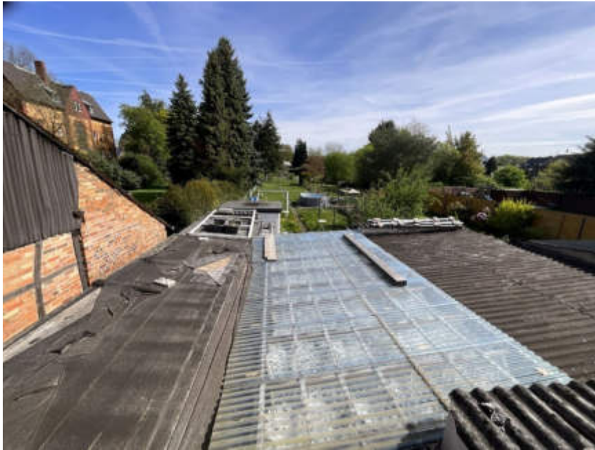
9) Anbauten / Terrassenüberdachung / Garage
