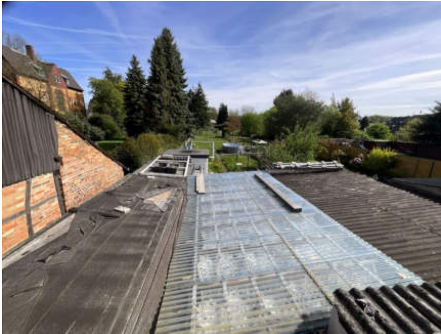
9) Anbauten / Terrassenüberdachung / Garage
