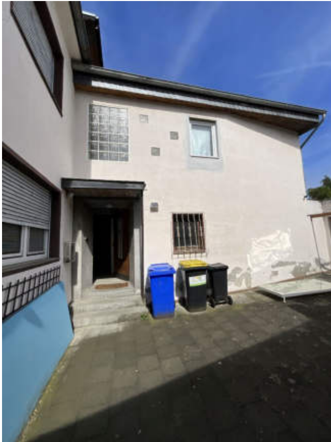
3) Hauseingang Anbau / Hof
