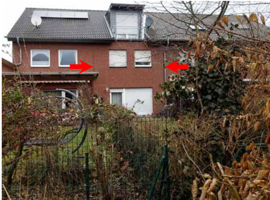
Rückansicht des Wohnhauses
