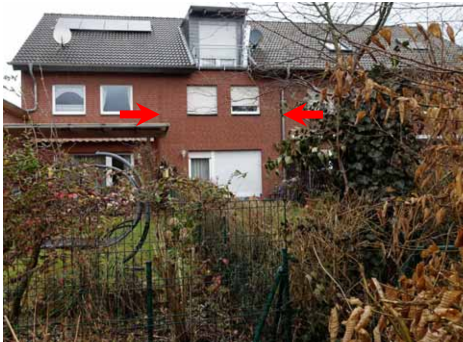
Rückansicht des Wohnhauses
