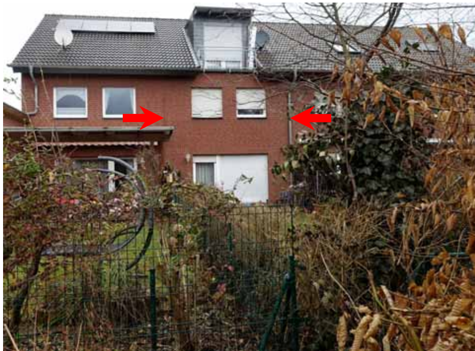
Rückansicht des Wohnhauses
