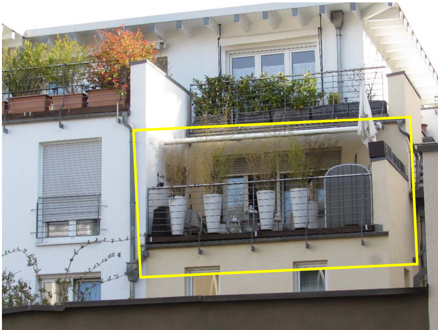
Foto 6: Wohnung Nr. 28 (rückwärtige Ansicht)
