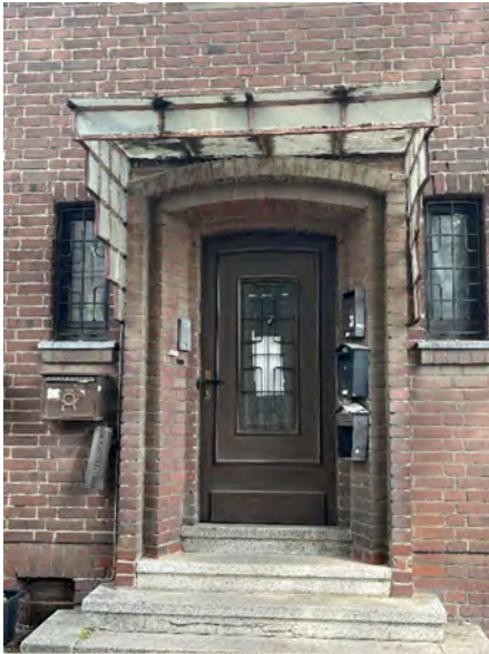
Bild 5: Ansicht des Hauseingangsbereichs
