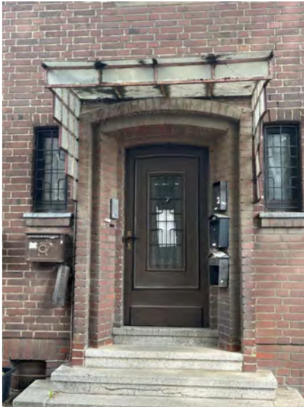
Bild 5: Ansicht des Hauseingangsbereichs
