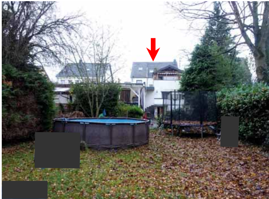
Rückansicht der Gebäude, rückwärtiger Grundstücksbereich
