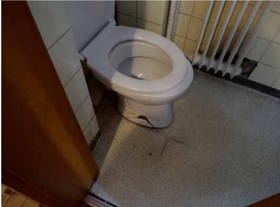
WC / Abstellraum im Erdgeschoss
