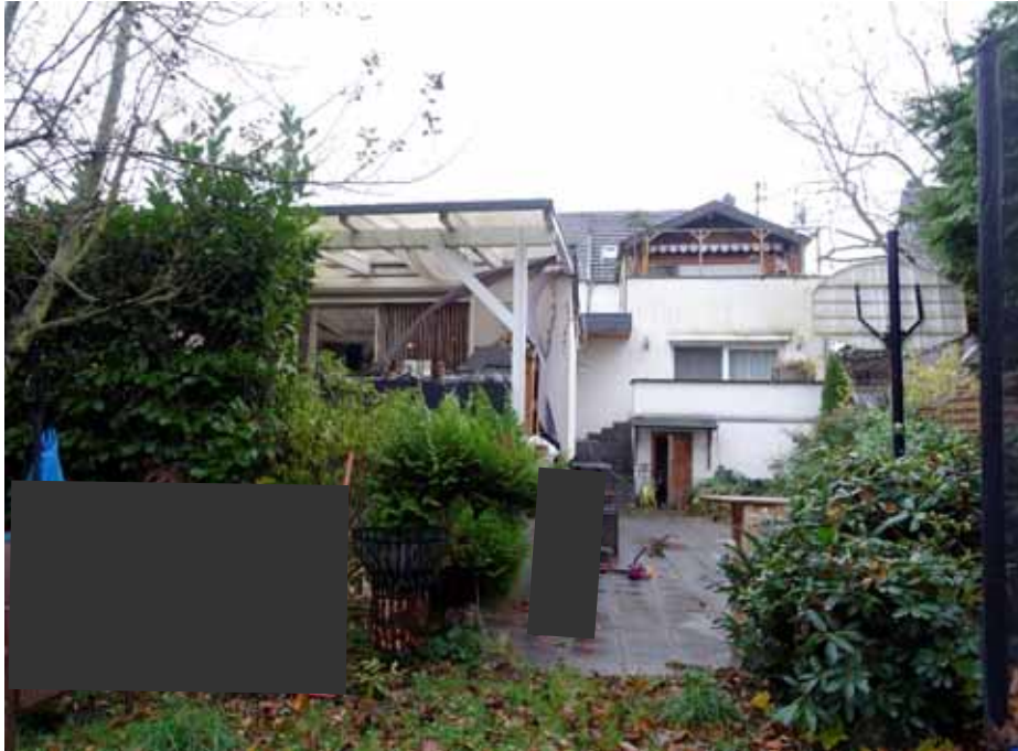
Rückansicht der Gebäude
