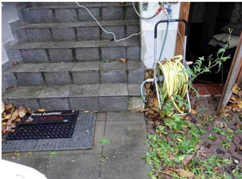
zur Erdgeschossterrasse führende Außentreppe
