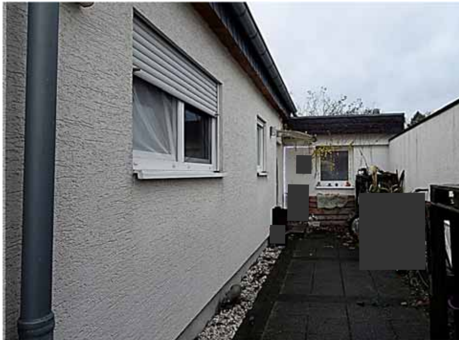
Seitenansicht des Anbaus II, Frontansicht des Anbaus III
