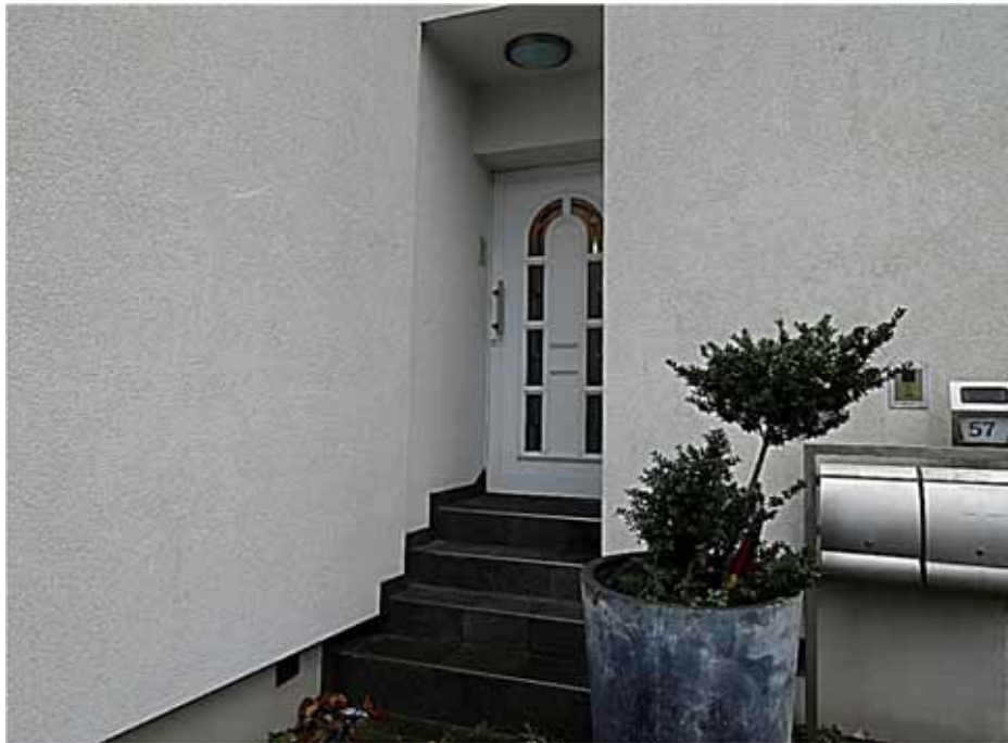
Eingangsbereich des Vorderhauses
