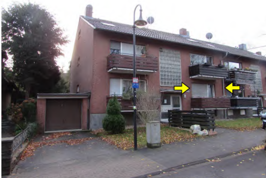
Foto 1: Mehrfamilienhaus "Schlangenpfad XX", Hürth-Alt-Hürth, Eigentumswohnung Nr. 2
