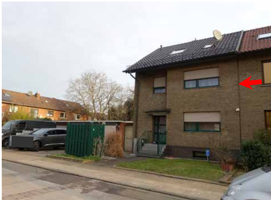
Dreikönigenstraße, Blick Richtung Nordwesten, Einfamilien-Doppelhaushälfte „Dreikönigenstraße 4“
