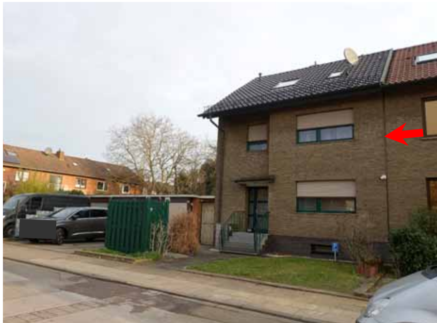
Dreikönigenstraße, Blick Richtung Nordwesten, Einfamilien-Doppelhaushälfte „Dreikönigenstraße 4“
