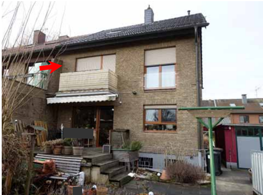
Rückansicht des Wohnhauses
