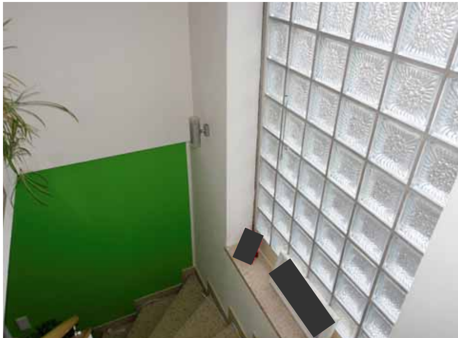
zum Obergeschoss führende Treppe
