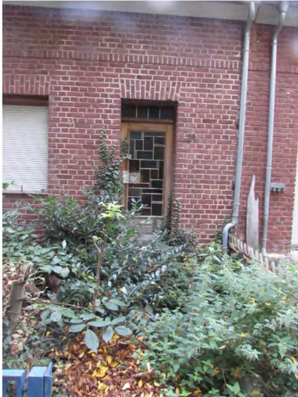
Foto 3: Hauseingang, verwilderte Eingrünung im vorderen Grundstücksbereich
