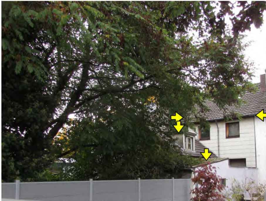
Foto 5: rückwärtige Ansicht von der Straße "An der Schleifmühle": Wohnhaus mit rückwärtigem Anbau, Schuppen
