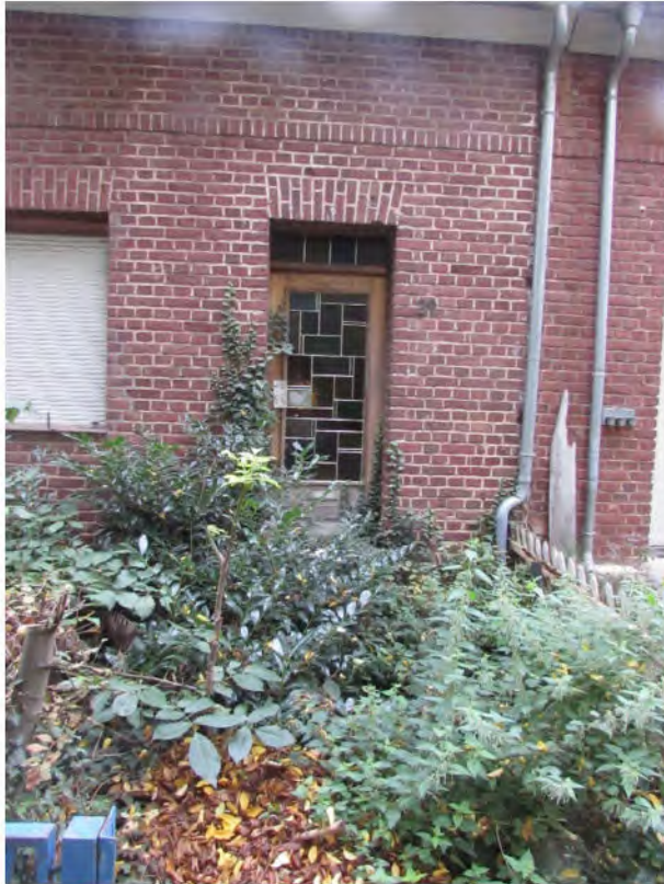
Foto 3: Hauseingang, verwilderte Eingrünung im vorderen Grundstücksbereich
