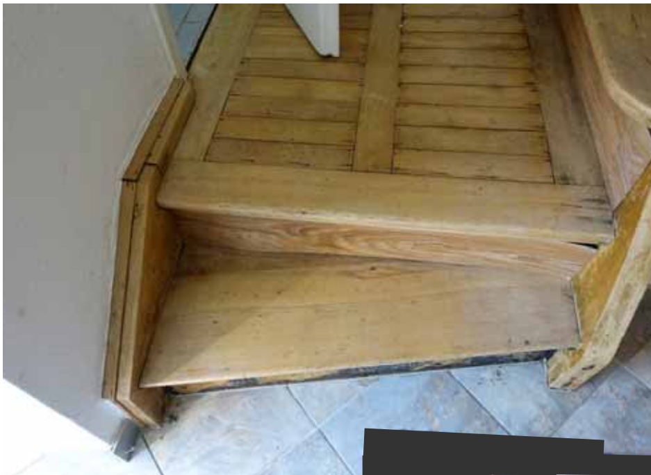
zum Obergeschoss führende Holzterppe
