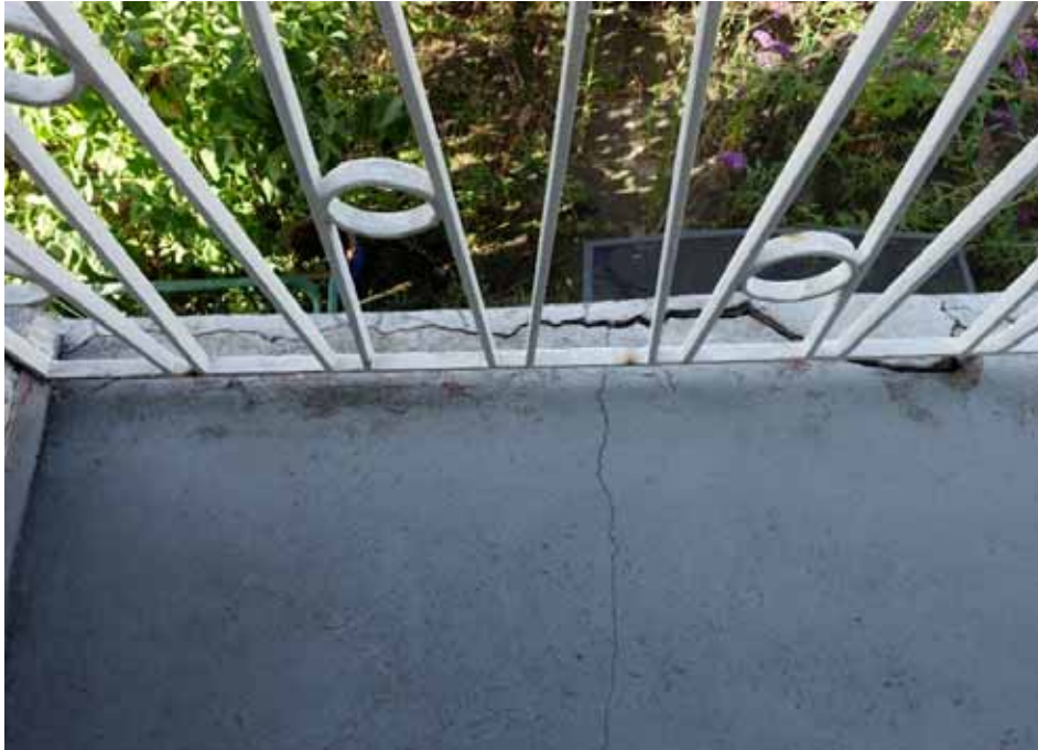
beschädigte Balkonplatte
