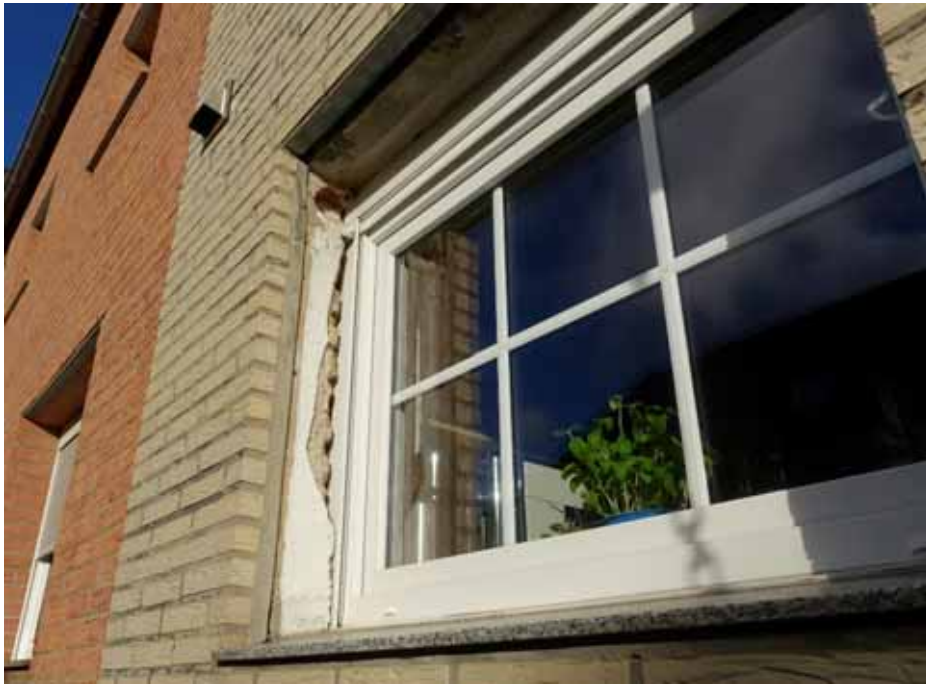
beschädigte Fensterlaibungen
