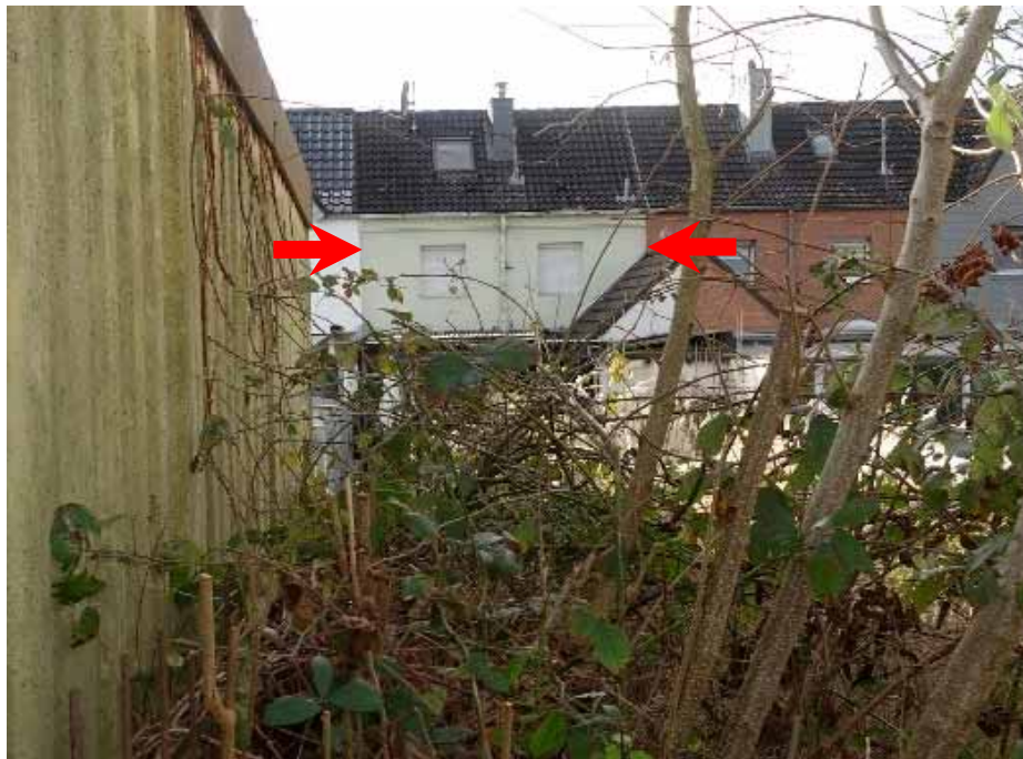
Hausgrundstück Flurstück 851, Rückansicht des Wohnhauses
