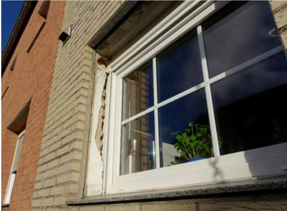
beschädigte Fensterlaibungen
