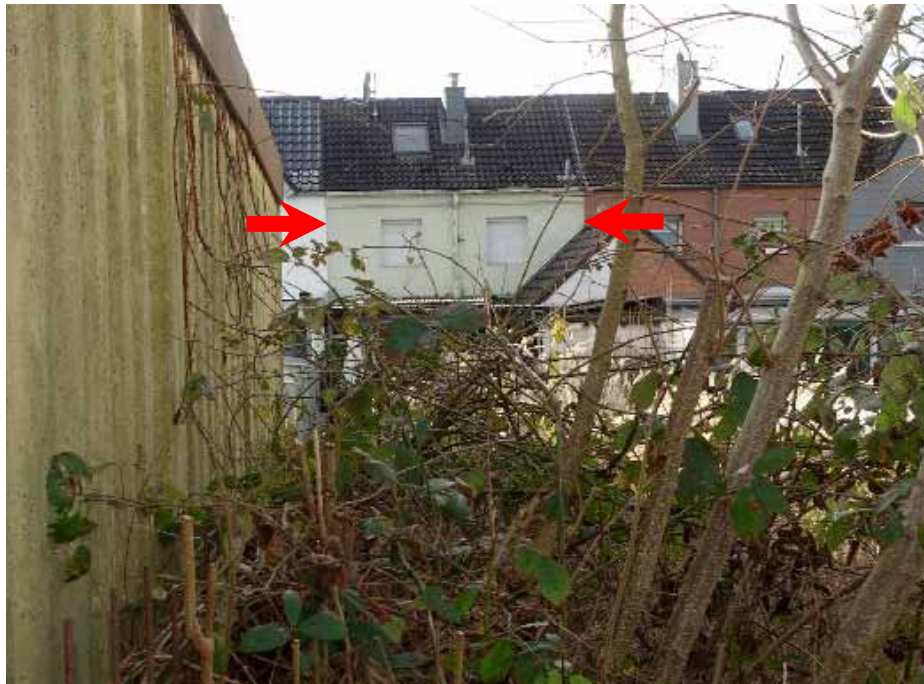
Hausgrundstück Flurstück 851, Rückansicht des Wohnhauses
