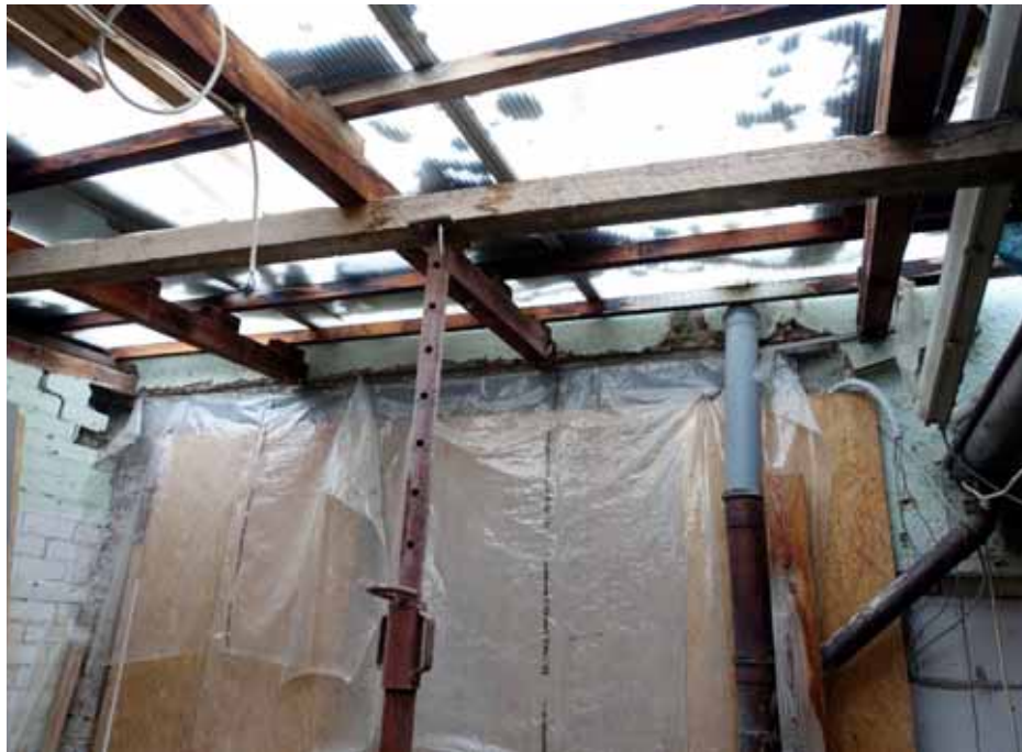
rückwärtige Wand des Erdgeschosses bzw. des Wohnzimmers, Blick vom Innenhof aus
