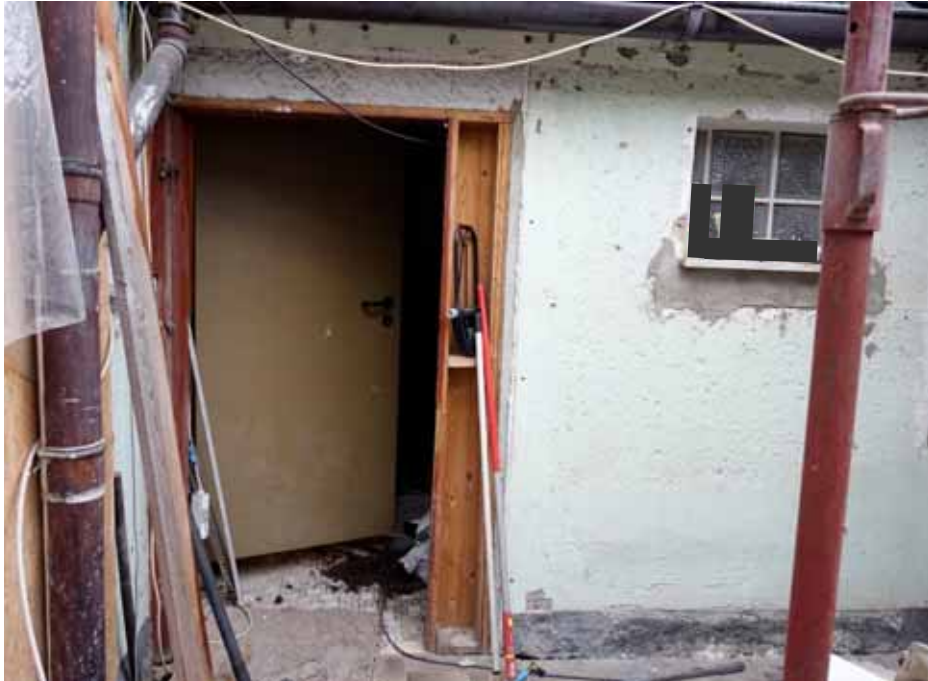
Zugang vom Innenhof aus zum Abstellraum (Anbau)
