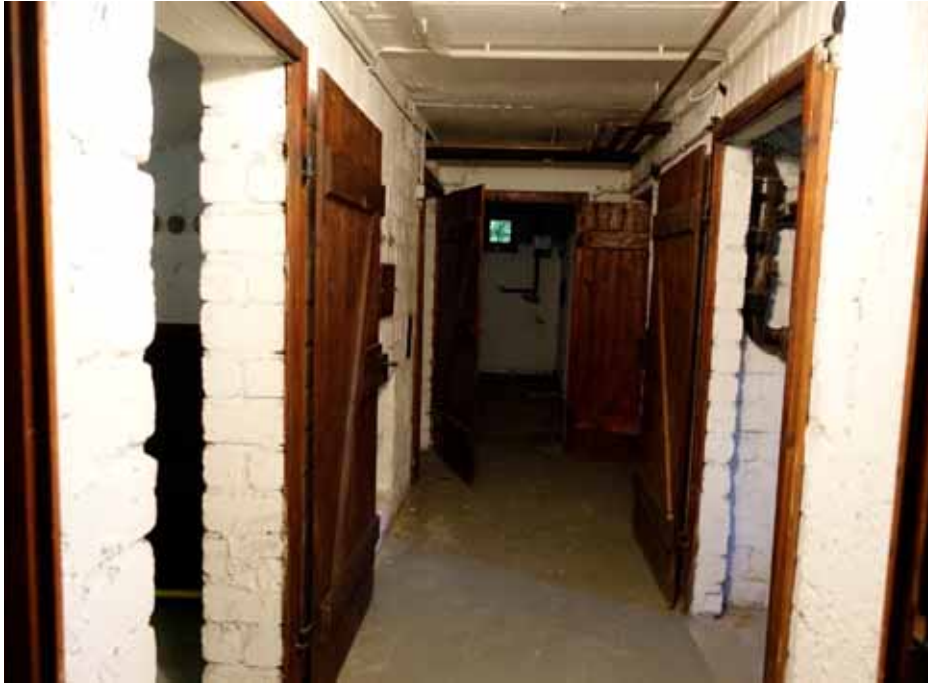
Flur des Kellergeschosses
