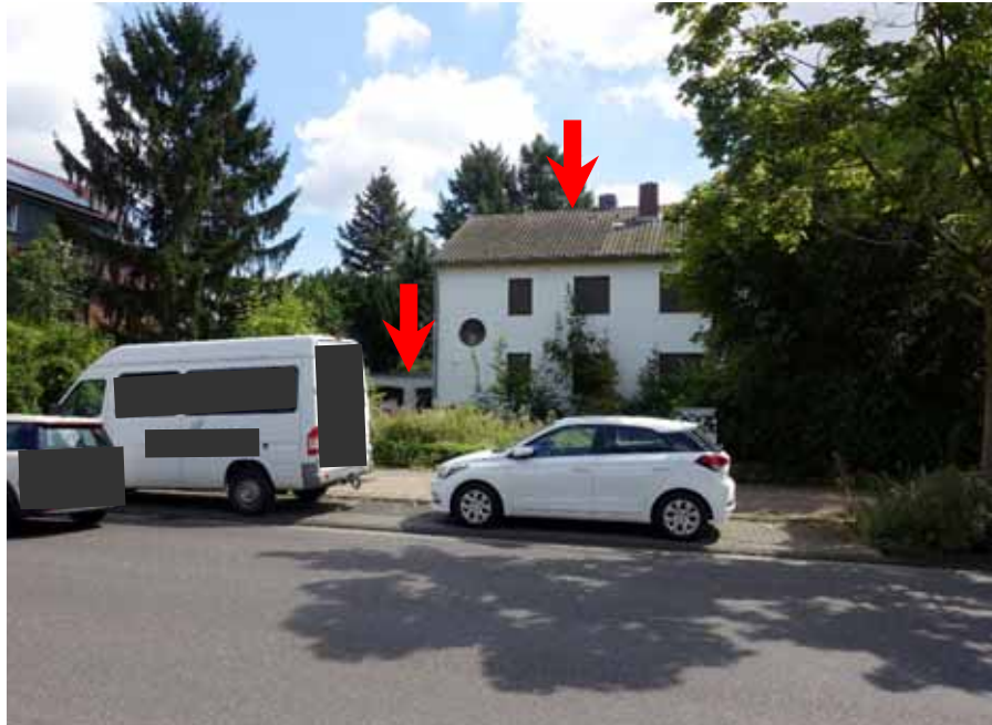
Krankenhausstraße, Blick Richtung Nordosten, Zweifamilienhaus „Krankenhausstraße 70“ mit zwei Pkw-Garagen
