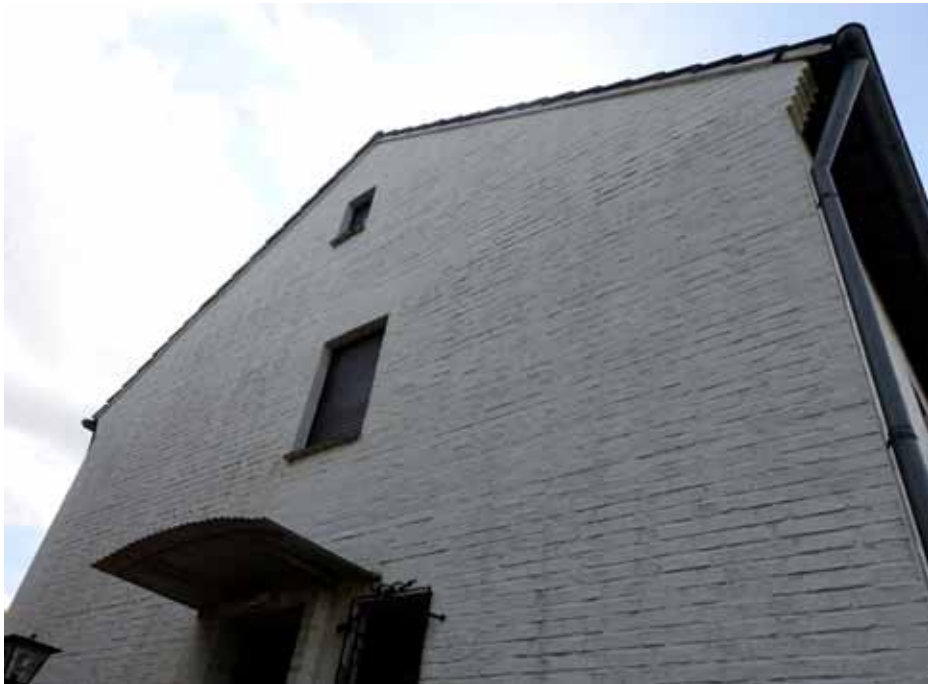
Seitenansicht des Wohnhauses, Hauseingangsbereich
