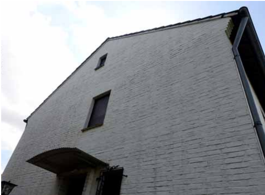
Seitenansicht des Wohnhauses, Hauseingangsbereich
