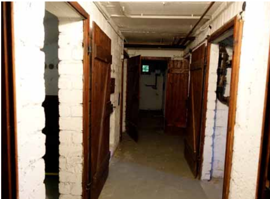
Flur des Kellergeschosses
