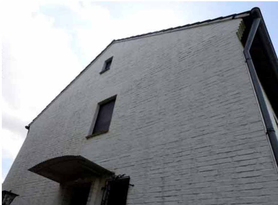
Seitenansicht des Wohnhauses, Hauseingangsbereich
