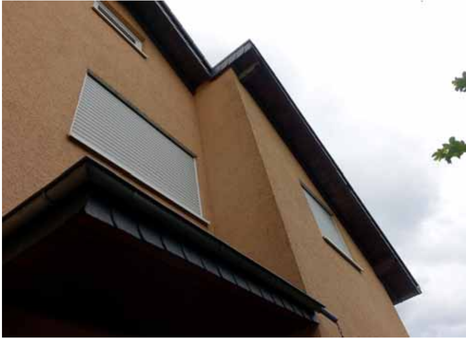
Seitenansicht des Wohnhauses, Hauseingangsbereich
