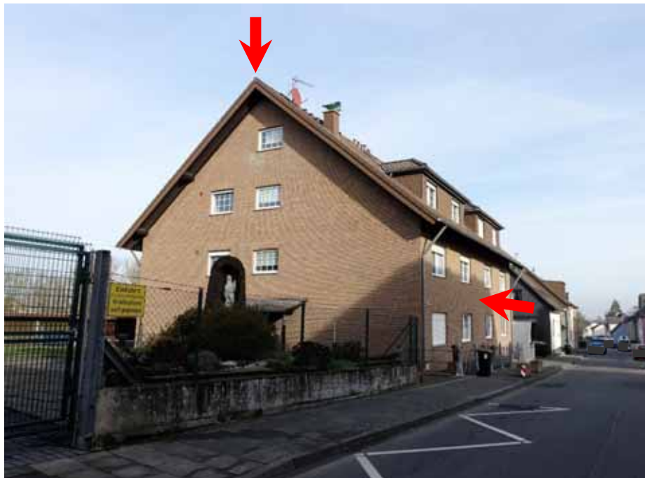
Eckdorfer Mühlenweg, Blick Richtung Nordosten, Mehrfamilienhaus „Eckdorfer Mühlenweg 7“
