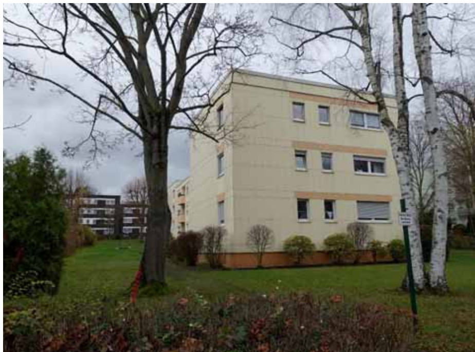
Ost- und Südfassade der Gebäude
