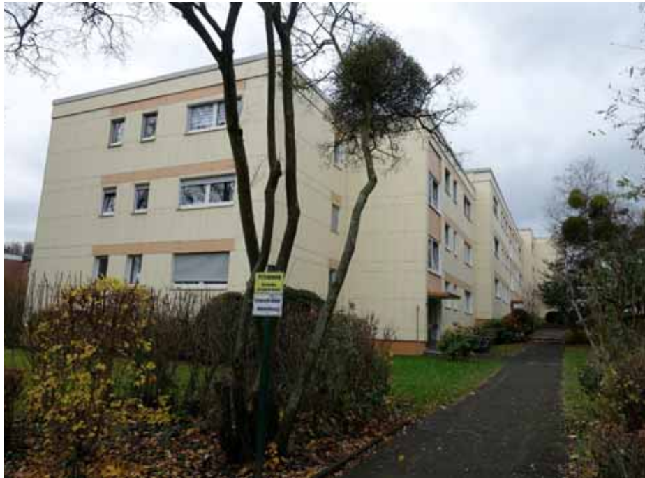
Ost- und Nordfassade der Gebäude, Blick von der „Von-Heinsberg-Straße“ aus
