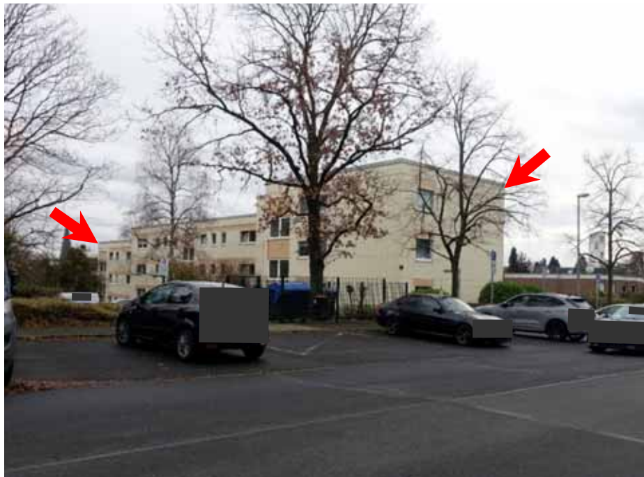
Wittelsbacherstraße, Blick Richtung Südosten, Wohnanlage „Wittelsbacherstraße 55, 57, 59“
